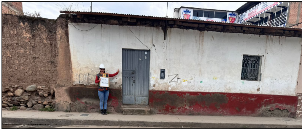
Edificio 1 – 1 piso (Jr. Crespo Castillo).
