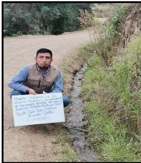
Se observa la cuneta del camino vecinal Loma Blanca (Aparicio Pomares)
