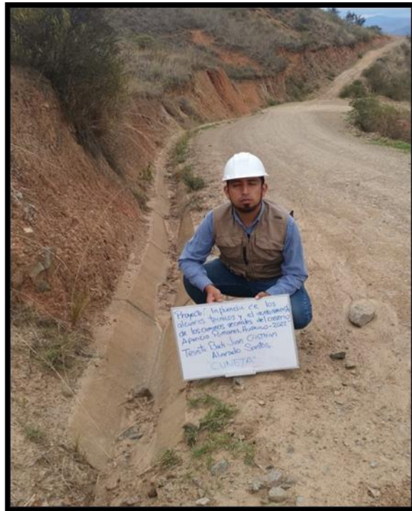
Se observa la cuneta del camino vecinal Loma Blanca (Aparicio Pomares)
