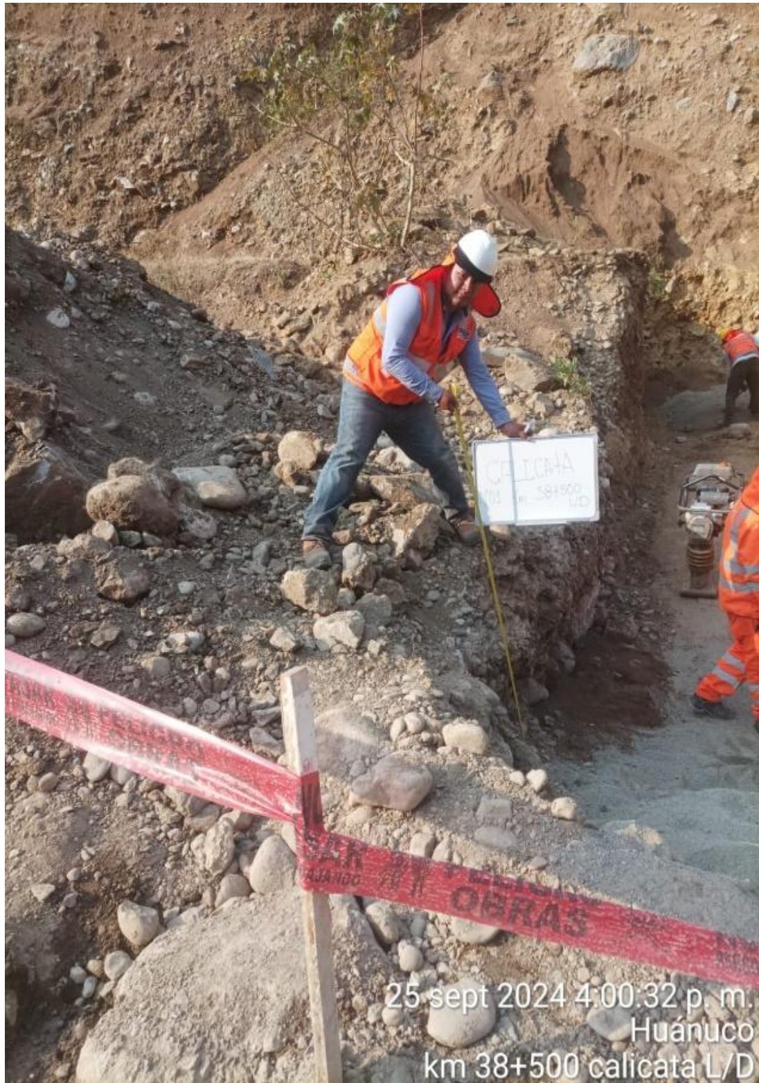
Exploración de suelos, extracción de muestra de la calicata -1. Corte de suelo para la construcción de superestructuras
