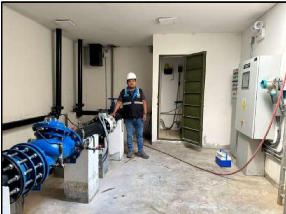
Figura 6 Infraestructura de la estación de bombeo - PP-01
