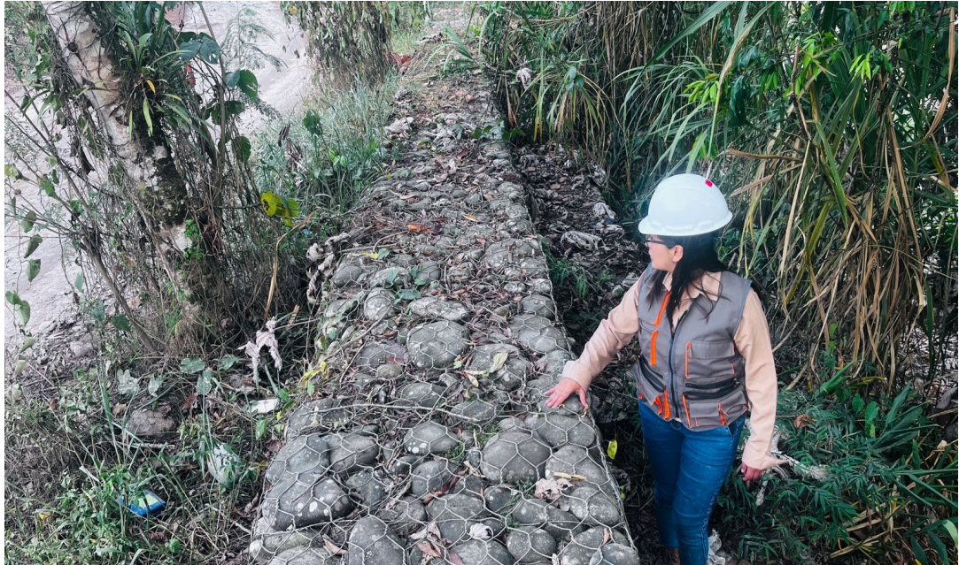
Inspección de gavión del margen derecho
