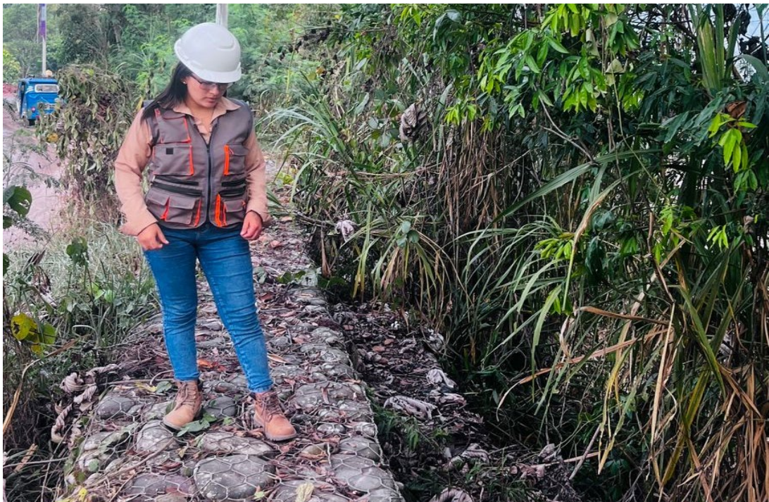
Inspección de muro de gaviones en el margen izquierdo
