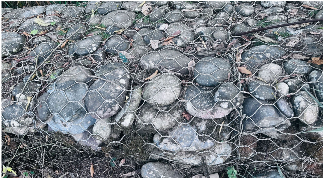
Inspección de la malla de los gaviones
