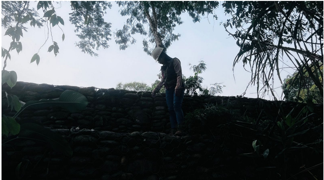
Verificación de gaviones ubicados en el margen
