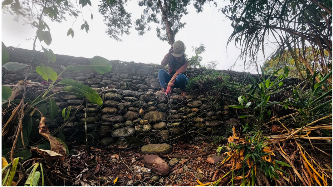
Inspección de estado de gaviones
