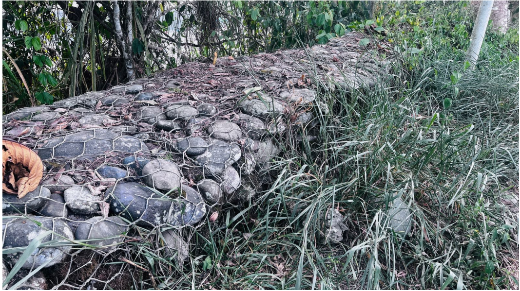
Muro de gaviones con restos orgánico
