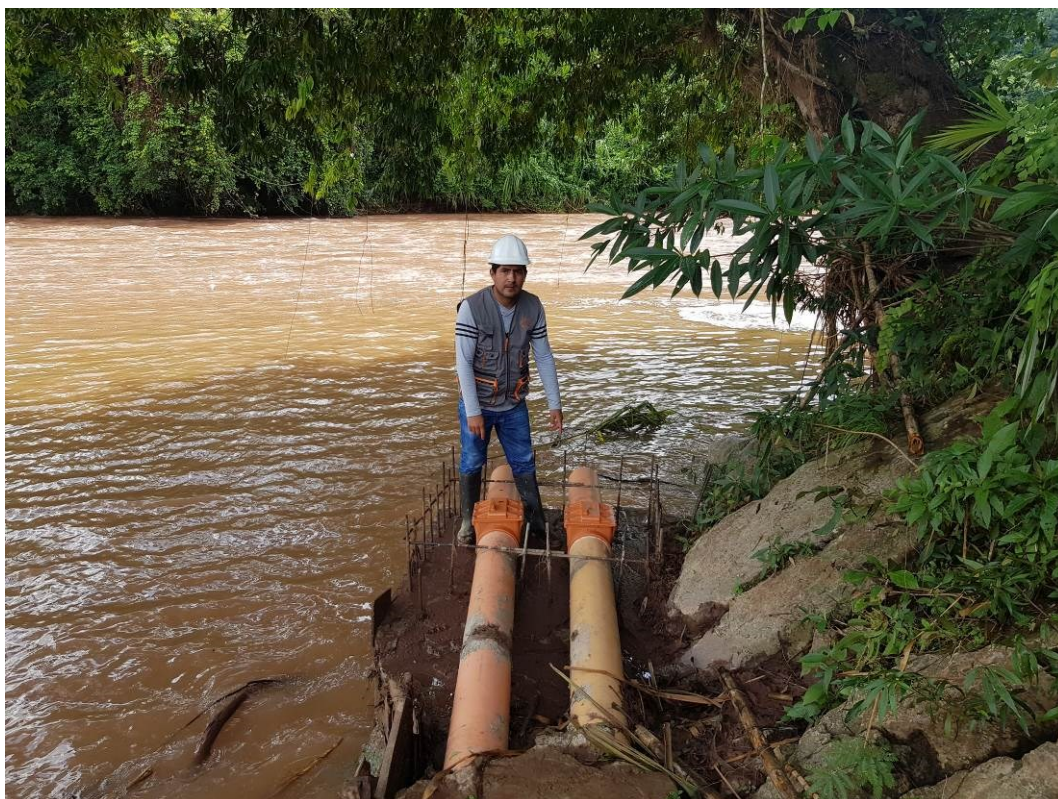
En la vista fotográfica se observa la instalación de la válvula Check en la PTAR de Pumahuasi
