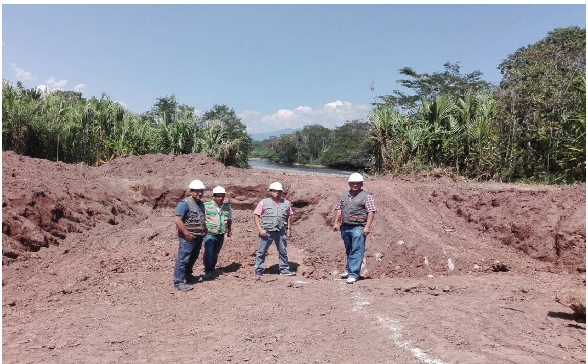
En la vista fotográfica se observa la Verificación del Trazo y Replanteo del Tanque Imhoff-Sector 1.
