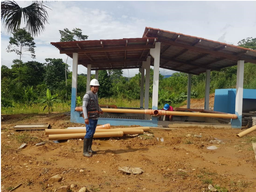
En la vista fotográfica se observa la PTAR de Mercedes culminando los últimos trabajos
