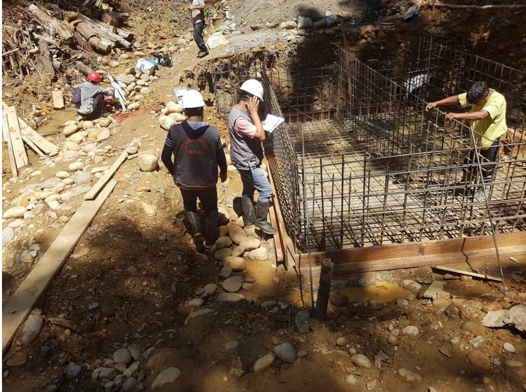
En la vista fotográfica se observa la realización del trabajo de armado de acero en sedimentador PTAP
