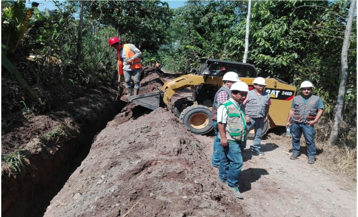
En la vista fotográfica se observa el Material Propio Seleccionado para la cama de apoyo y para la protección de la Tubería de PVC
