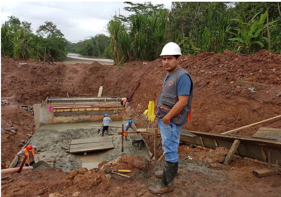
En la vista fotográfica se observa la verificación del vaciado del cimiento del tanque imhoff
