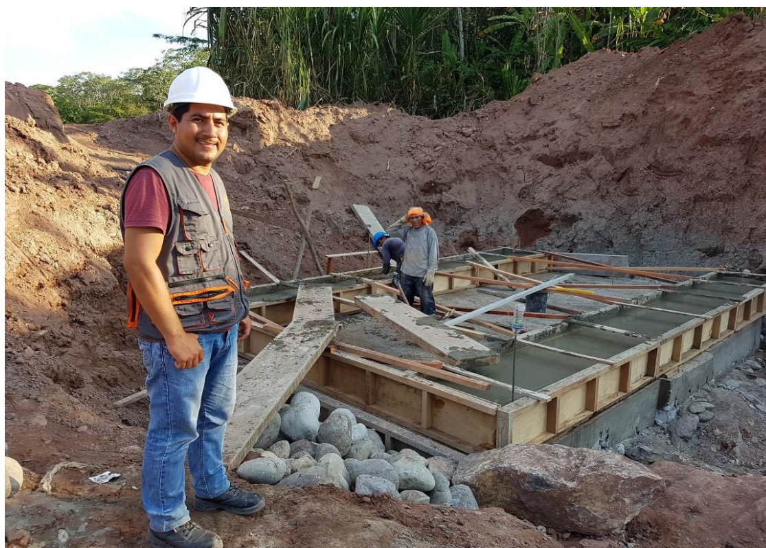
En la vista fotográfica se observa la verificación del vaciado del cimiento del filtro biológico
