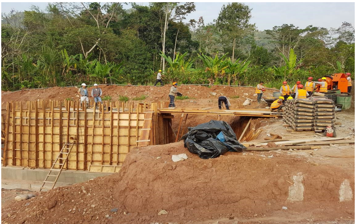
En la vista fotográfica se observa la supervisión verificando el encofrado del muro del tanque biológico y tanque imhoff de la PTAR 1
