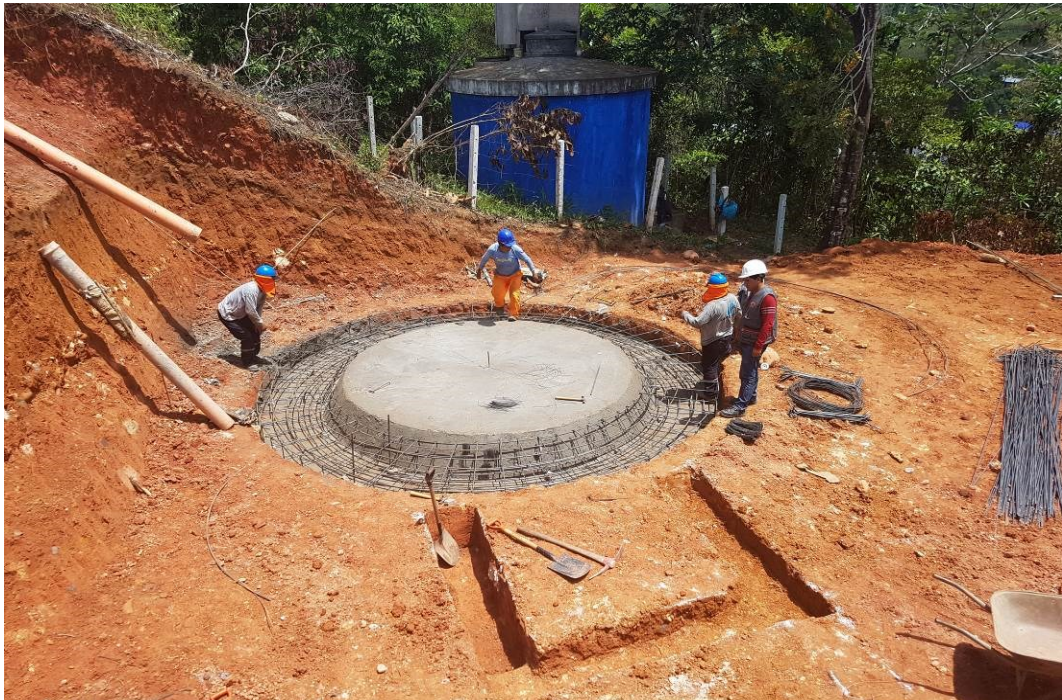
En la vista fotográfica se observa los trabajos de vaciado y armado de acero para cimiento de reservorio
