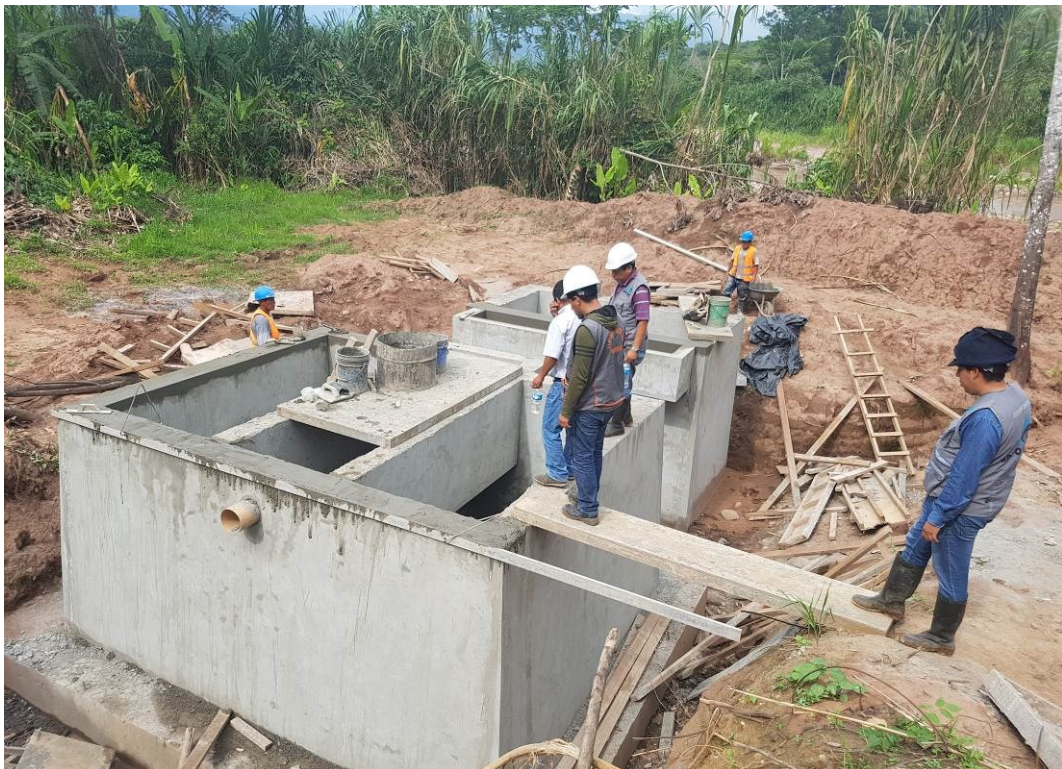
En la vista fotográfica se observa la supervisión verificando los trabajos de tarrajeo de muros del tanque imhoff y biofiltro de la PTAR 2
