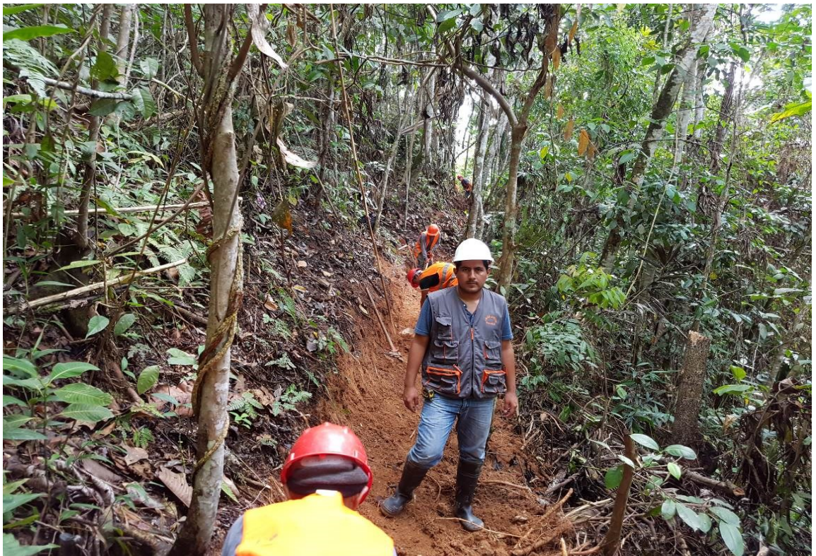
En la vista fotográfica se observa a la Supervisión verificando el enterrado de tuberías de la línea de conducción con tubería PVC de D=4"
