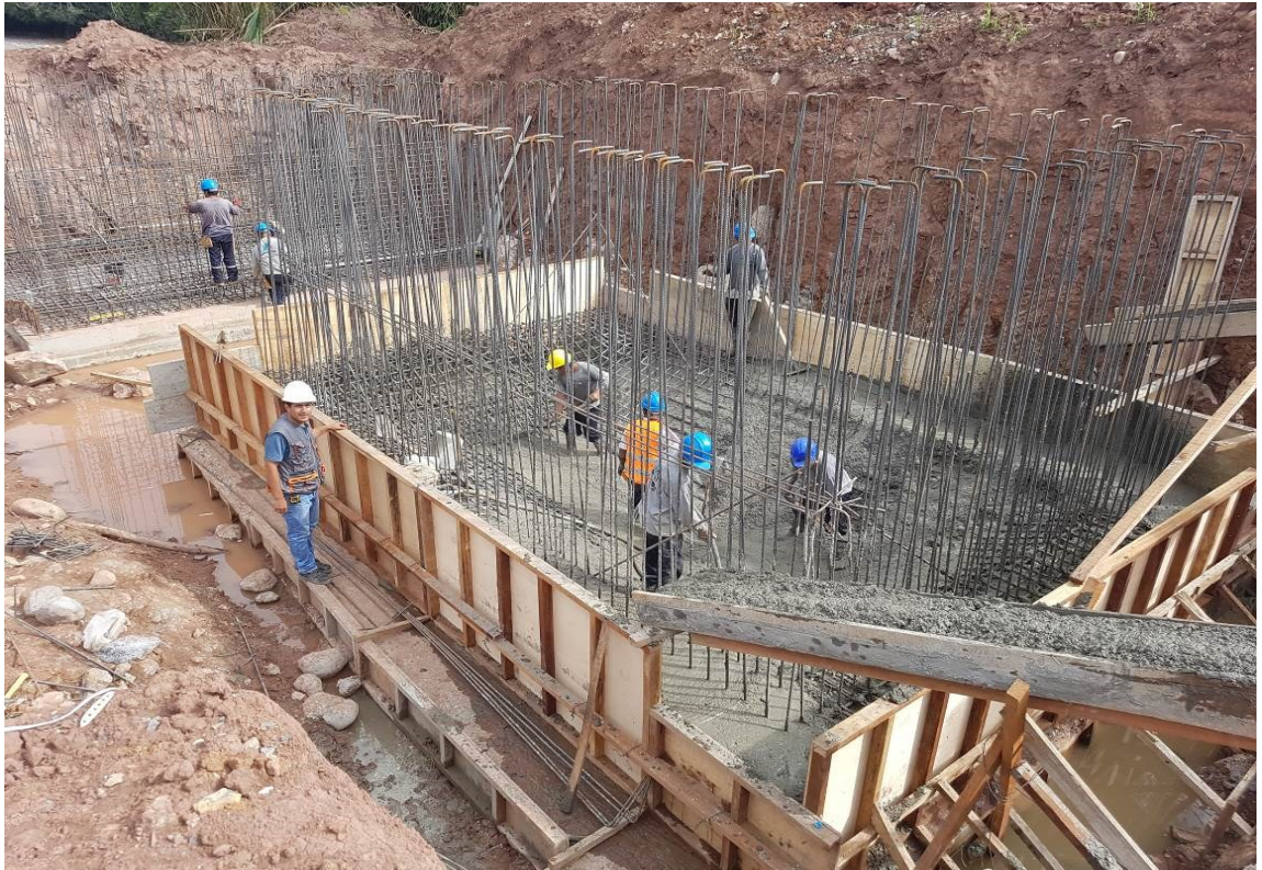
En la vista fotográfica se observa la supervisión verificando el vaciado del cimiento del tanque imhoff de la PTAR 1
