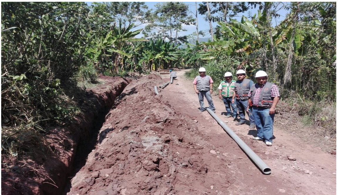
En la vista fotográfica se observa a la Supervisión verificando la Tubería PVC de D=4" para la Línea de Conducción del Agua Potable
