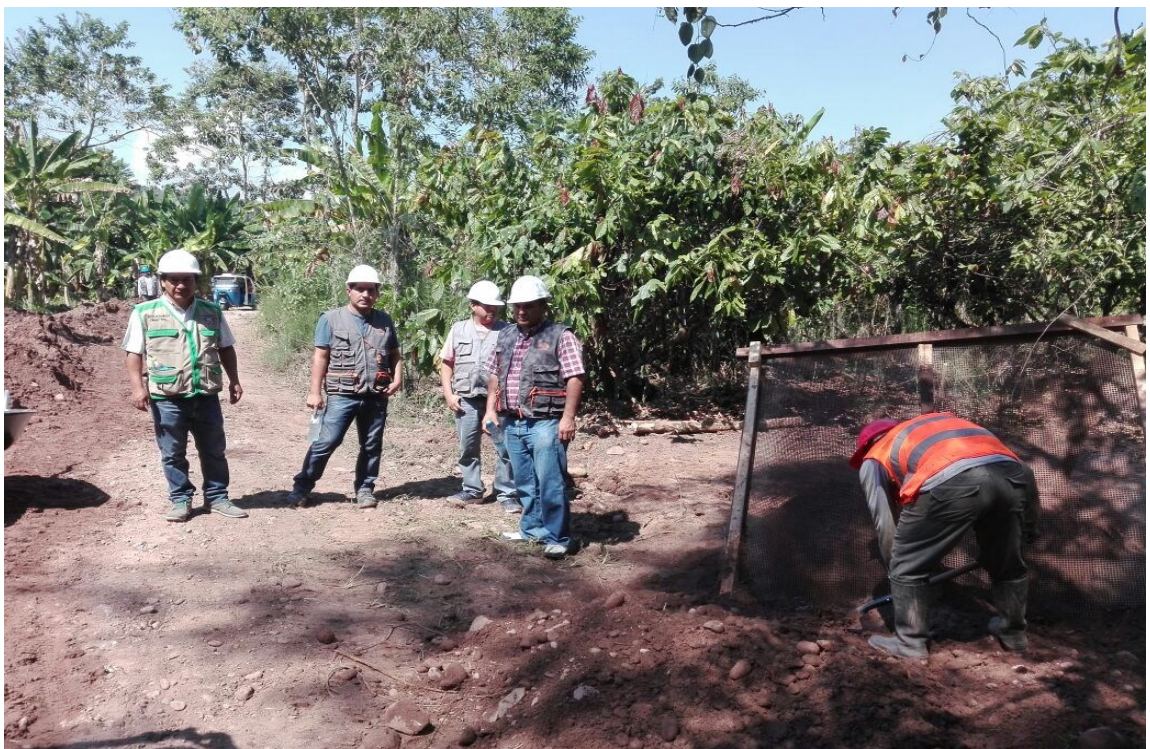
En la vista fotográfica se observa la verificación del Material Propio Seleccionado para la cama de apoyo y para la protección de la Tubería de PVC.
