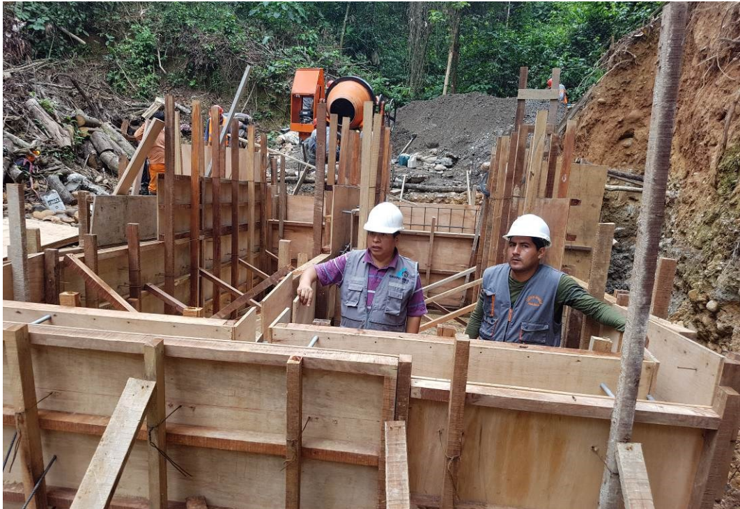
En la vista fotográfica se observa la supervisión verificando los trabajos de encofrado y vaciado de muros del sedimentador PTAP
