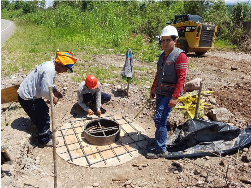
En la vista fotográfica se observa a la Supervisión verificando los trabajos de encofrado y vaciado de tapas de buzones en la localidad de Chancadora
