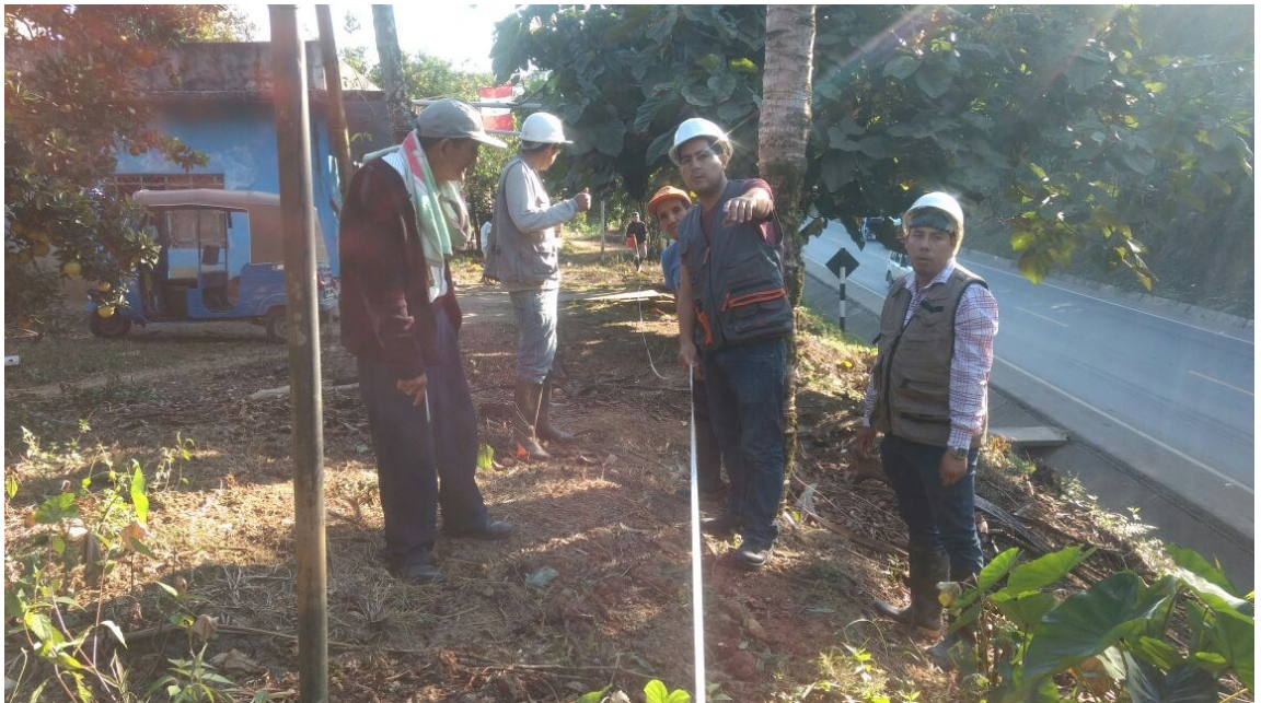
En la vista fotográfica se observa el Trazo y Replanteo de la red de alcantarillado de la localidad de Mercedes
