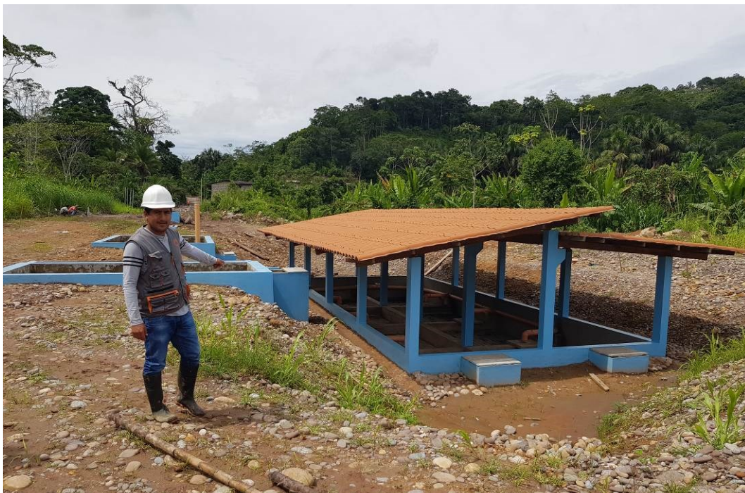
En la vista fotográfica se observa la PTAR de Pumahuasi culminado los trabajos de Cerco Perimétrico
