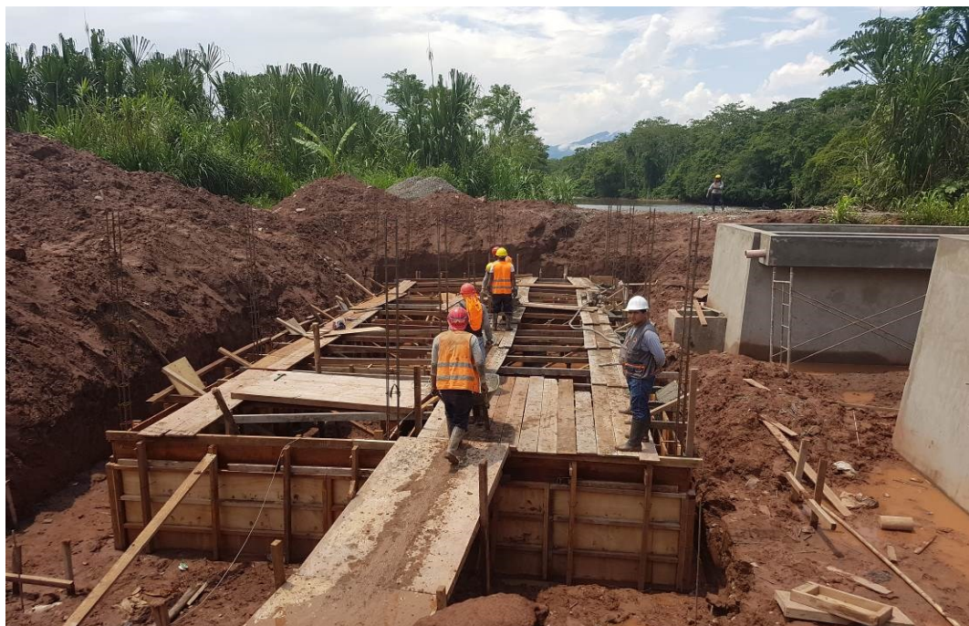
En la vista fotográfica se observa la supervisión verificando los trabajos de vaciado de concreto en muros de lecho de secado – Pumahuasi
