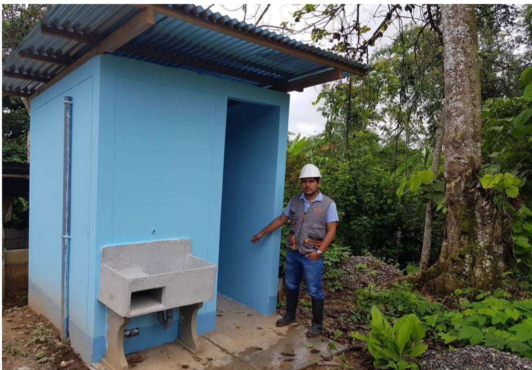
En la vista fotográfica se observa las casetas UBS culminando los últimos trabajos
