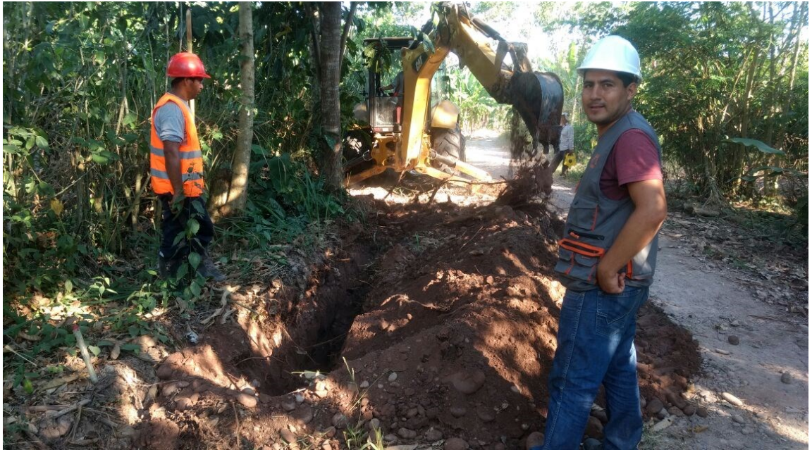
En la vista fotográfica se observa la verificación de la Excavación de Zanja para la Línea de Conducción del Agua Potable con Retro Excavadora.
