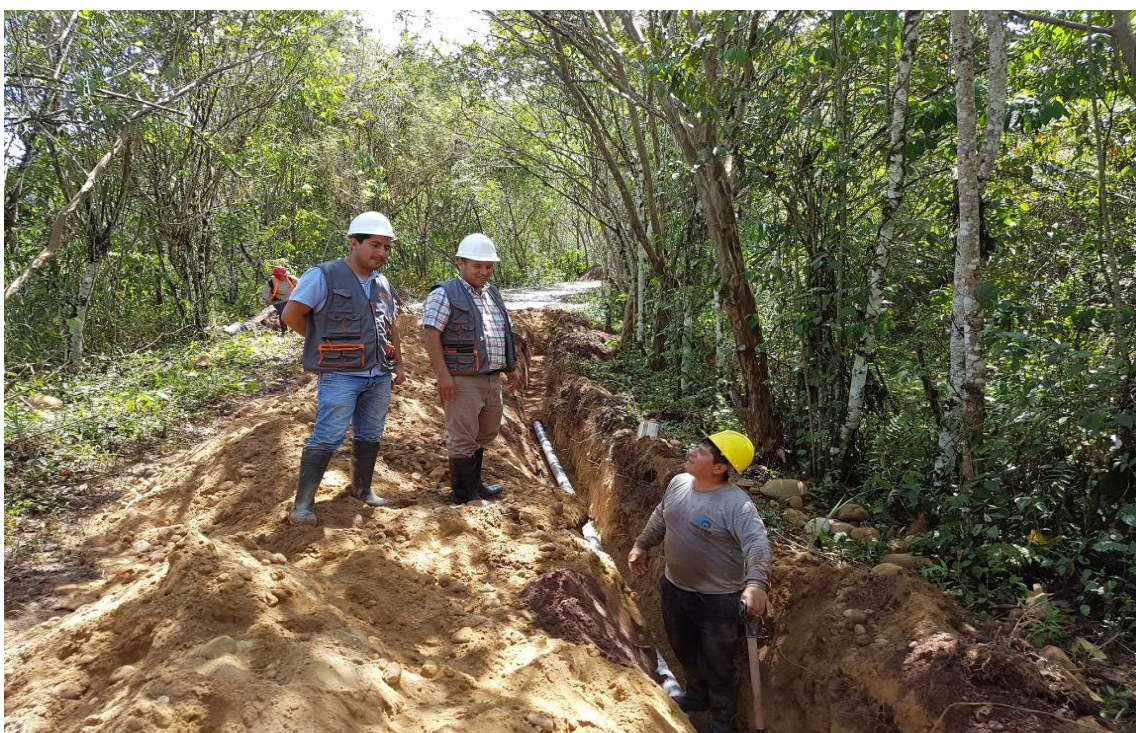
En la vista fotográfica se observa la supervisión verificando el enterrado de tubería de la línea de conducción
