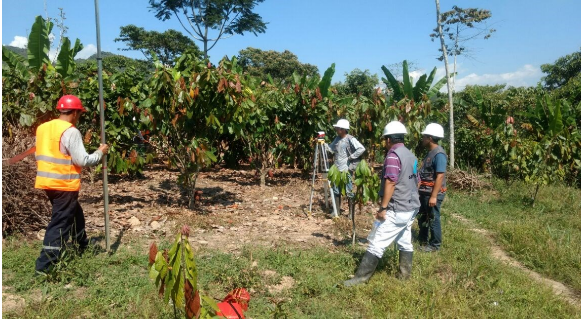
En la vista fotográfica se observa la verificación del Trazo y Replanteo de la red de alcantarillado de la localidad de Mercedes
