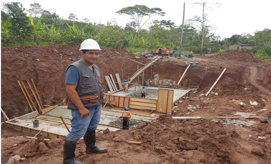
En la vista fotográfica se observa la verificación del vaciado del cimiento del tanque imhoff y filtro biológico
