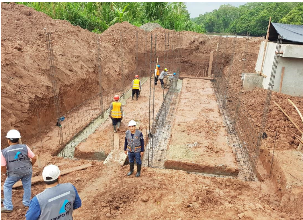
En la vista fotográfica se observa el trabajo de trazo armado de acero para lecho de secado - Pumahuasi.
