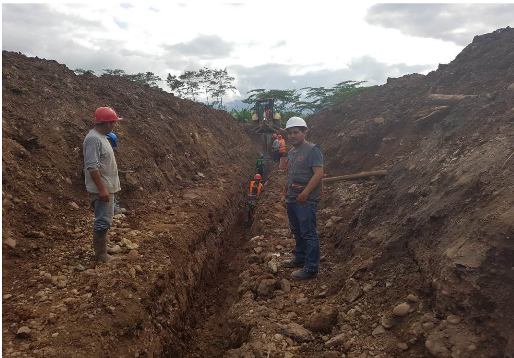
En la vista fotográfica se observa la realización del trabajo de excavación de 2.4 metros para tuberías de alcantarillado en Chancadora
