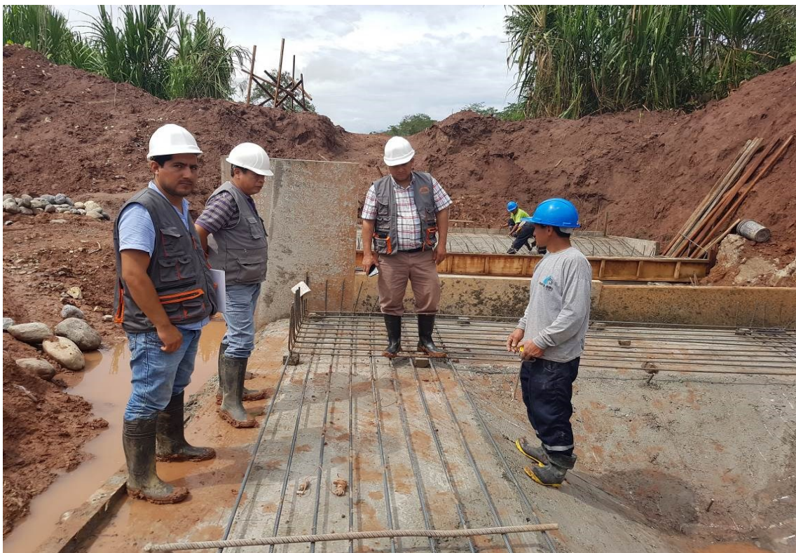
En la vista fotográfica se observa la supervisión verificando el armado de acero del cimiento del tanque imhoff de la planta de tratamiento de Pumahuasi
