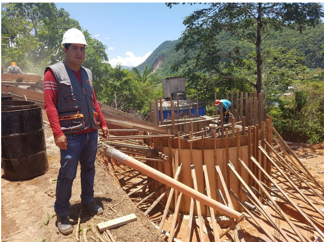
En la vista fotográfica se observa la supervisión verificando los trabajos de encofrado y vaciado de reservorio
