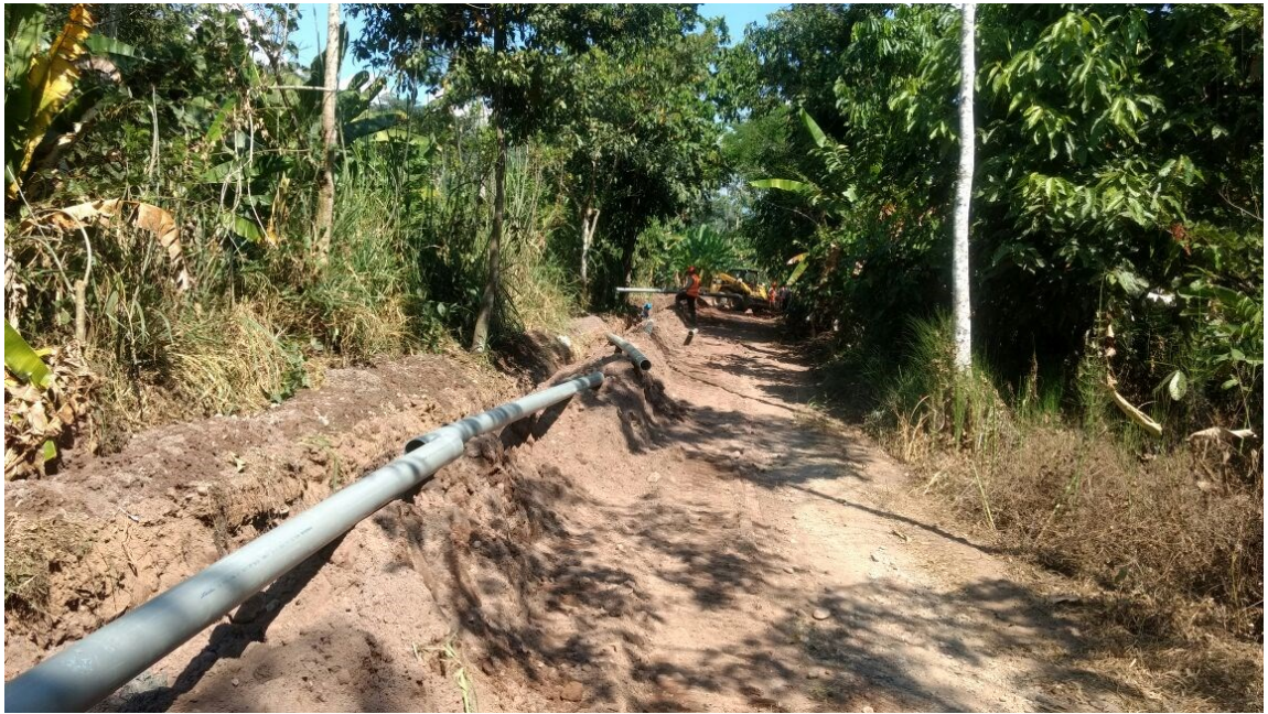
En la vista fotográfica se observa el Suministro e Instalación de Tubería PVC de D=4" para la Línea de Conducción del Agua Potable.
