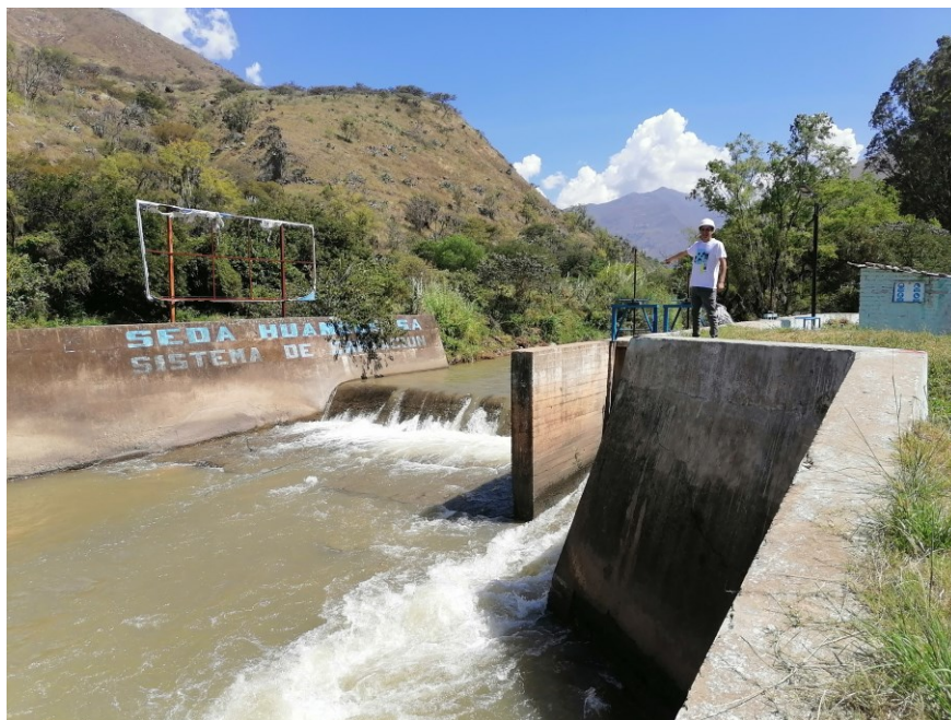
Captación del agua natural del río Higuera, ubicado en el lugar de Canchán.
