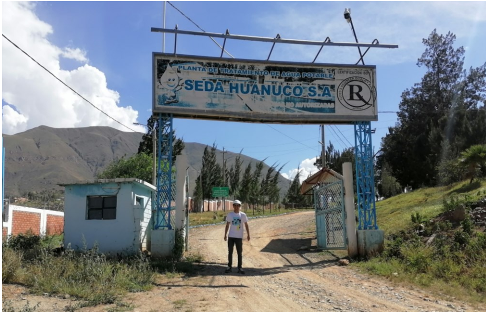
Planta de tratamiento ubicado en el lugar denominado Cabrito Pampa, parte alta de la Urbanización los carrizales.
