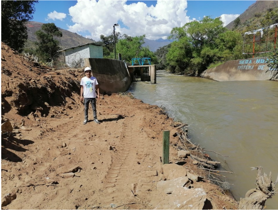
La captación se encuentra en mejoramiento.
