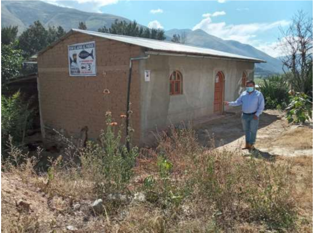
Evaluación de dicha vivienda situada en Nueva Aurora (aa. hh.) - Tomaykichwa
