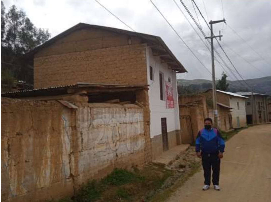
Evaluación de las viviendas del Jr. La Zanja
