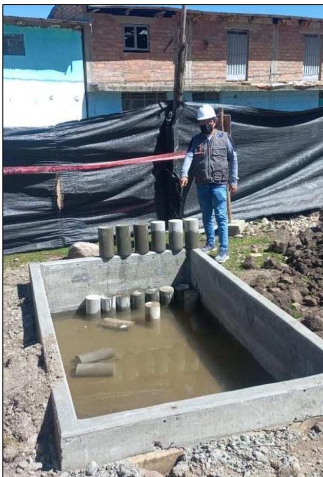
Curado de probetas de concreto
