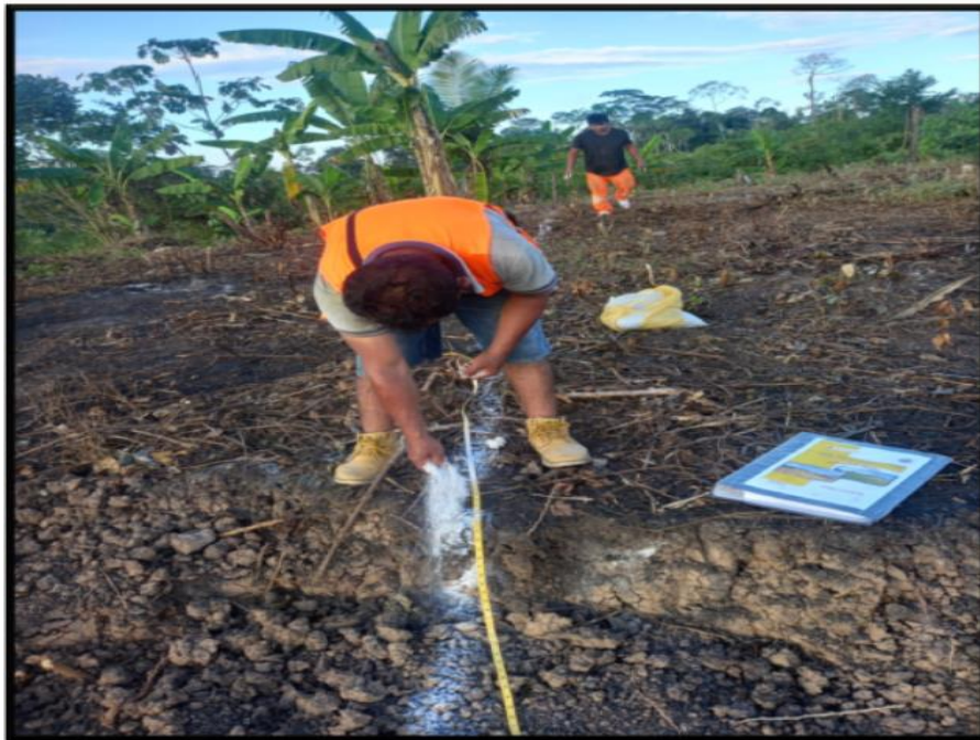
Inicio de los trabajos de trazo y replanteo
