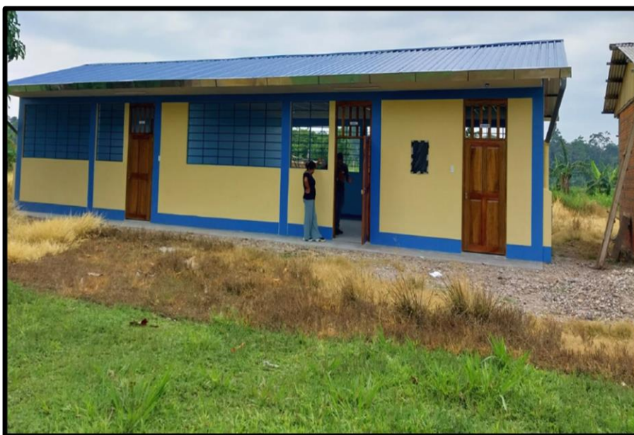
Fin y Entrega de Obra
