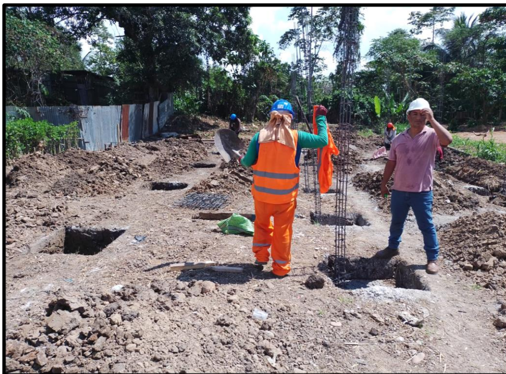
Izamiento de columnas con la supervisión de la Sub Gerencia de Obras Públicas, Estudios y Proyectos
