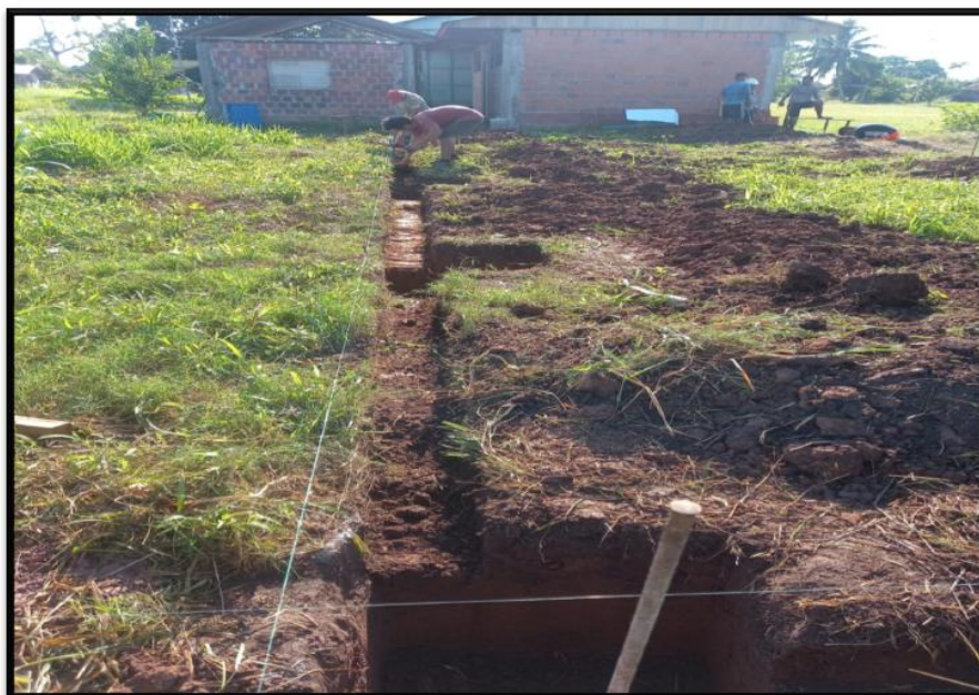
Excavación de zapatas y zanjas de cimentación
