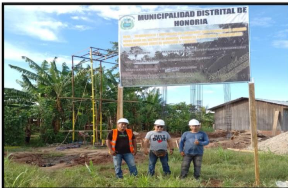
Inicio de la Obra 26/07/2022
