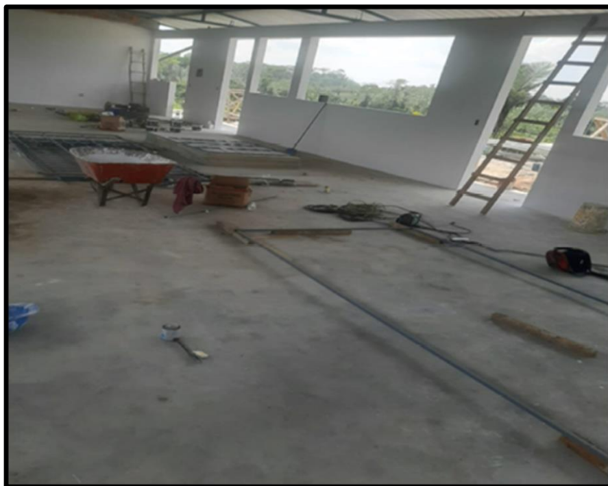
Pintado de muros de interiores
