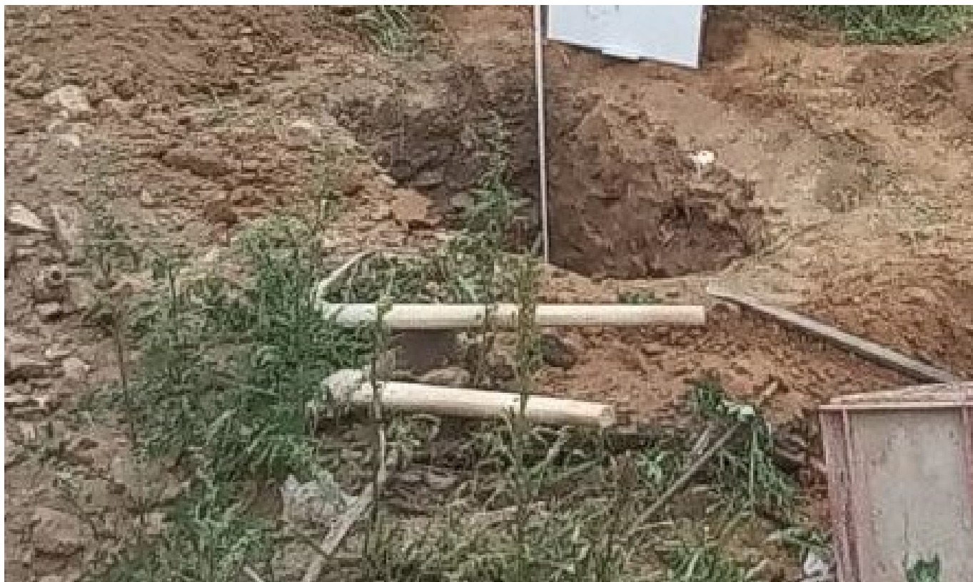
Calicata de almacén de acero
