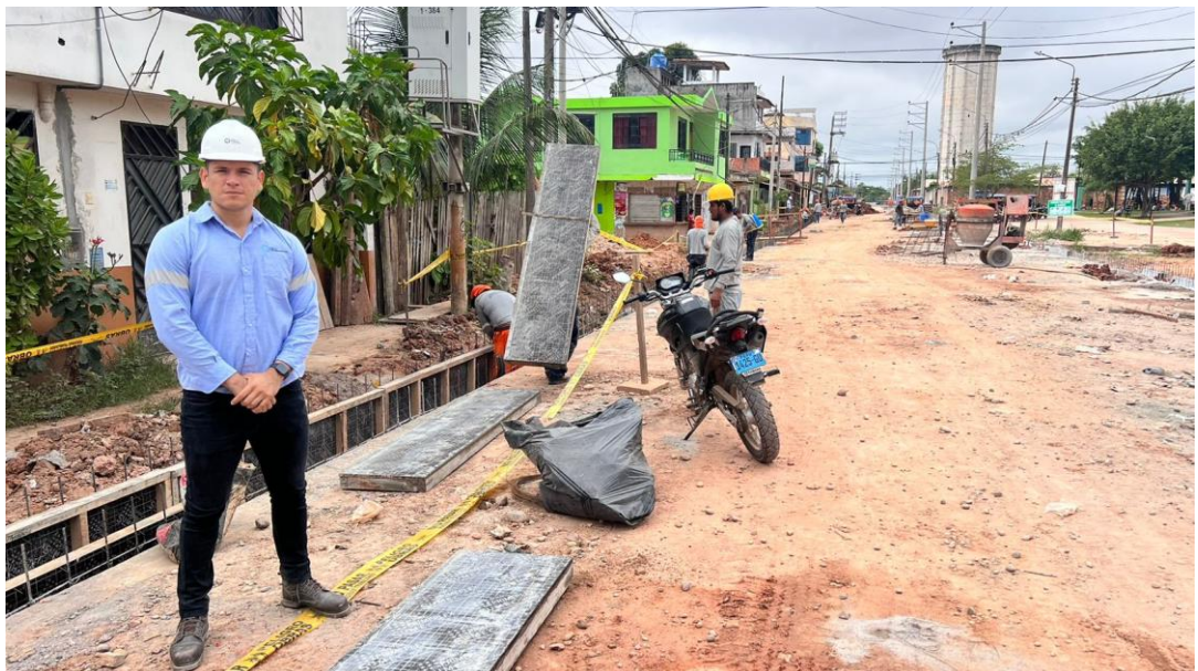
En la vista panorámica se observa los trabajos de encofrado y desencofrado en el sistema de drenaje, además se puede observar la loza de pavimento vial.
