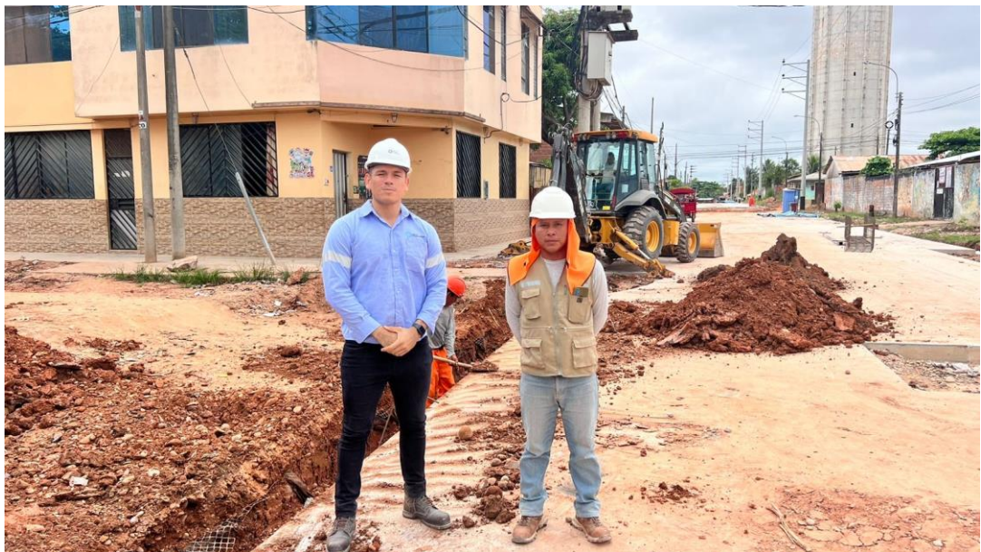
En la vista panorámica se puede observar los trabajos de excavación de zanja con maquinaria y los trabajos de perfilado del sistema de drenaje.
