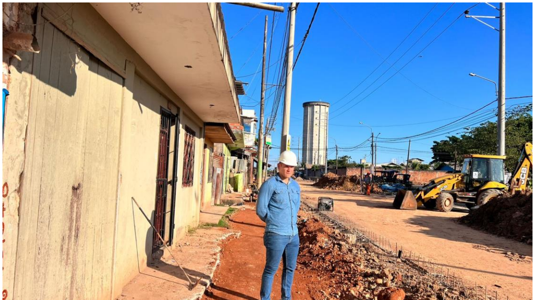
En la vista panorámica se observa los trabajos del sistema de drenaje, y los accesos peatonales de la vía, como también del pool de maquinarias.
