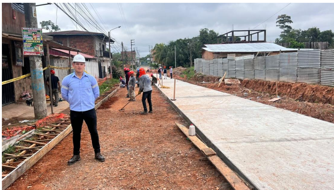
En la vista panorámica se observa los trabajos encofrado y desencofrado en pavimento o vía, preparación de la sub rasante para el vaciado del pavimento.
