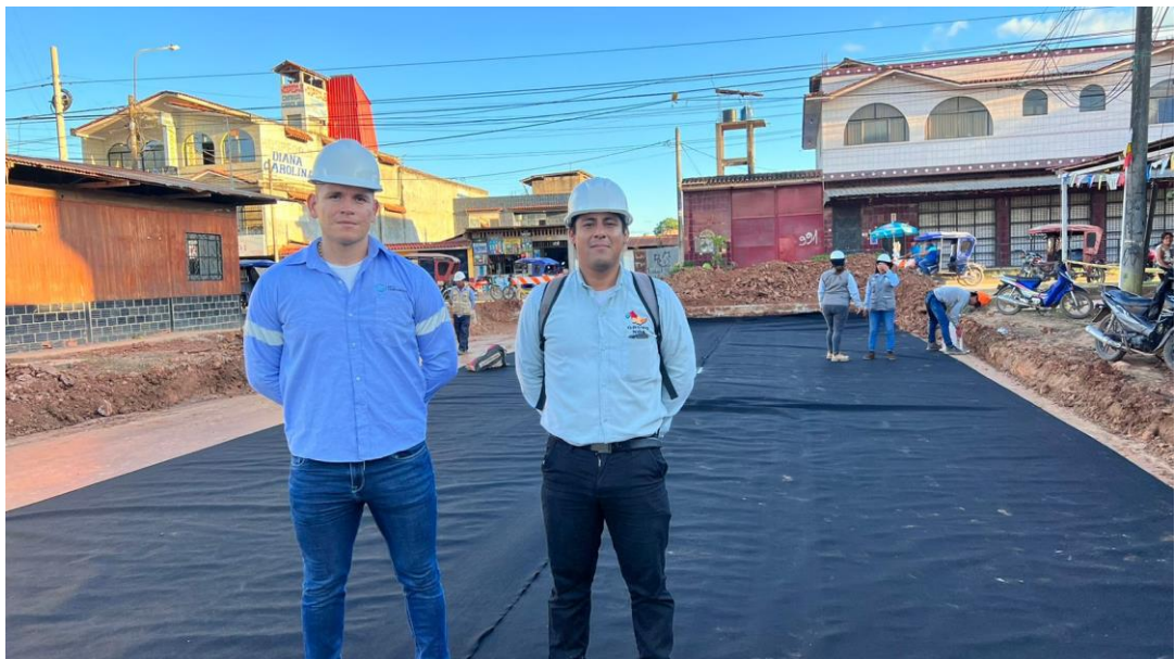
En la vista fotográfica se el tratamiento de la sub rasante con geotextiles, para así poder mejorar el CBR del suelo que se pide para la construcción de la vía.
