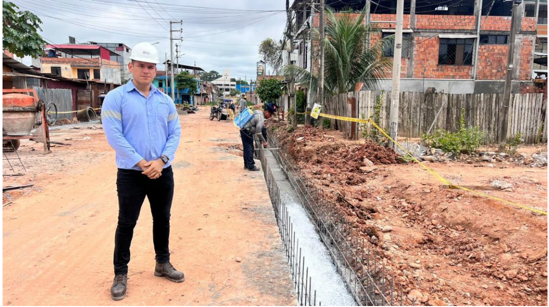
En la vista panorámica se observa la verificación de los trabajos ejecutados en la instalación del sistema de drenaje de la vía.
