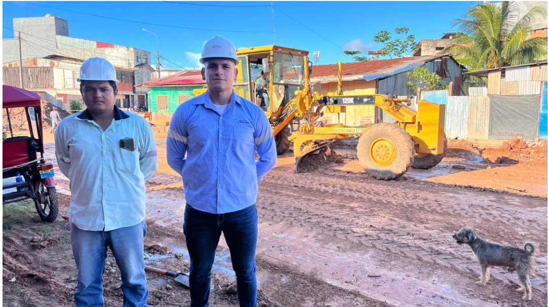
En la vista panorámica se observa el trabajo de las maquinarias (moto niveladora) para conformar la subrasante según diseño del pavimento.
