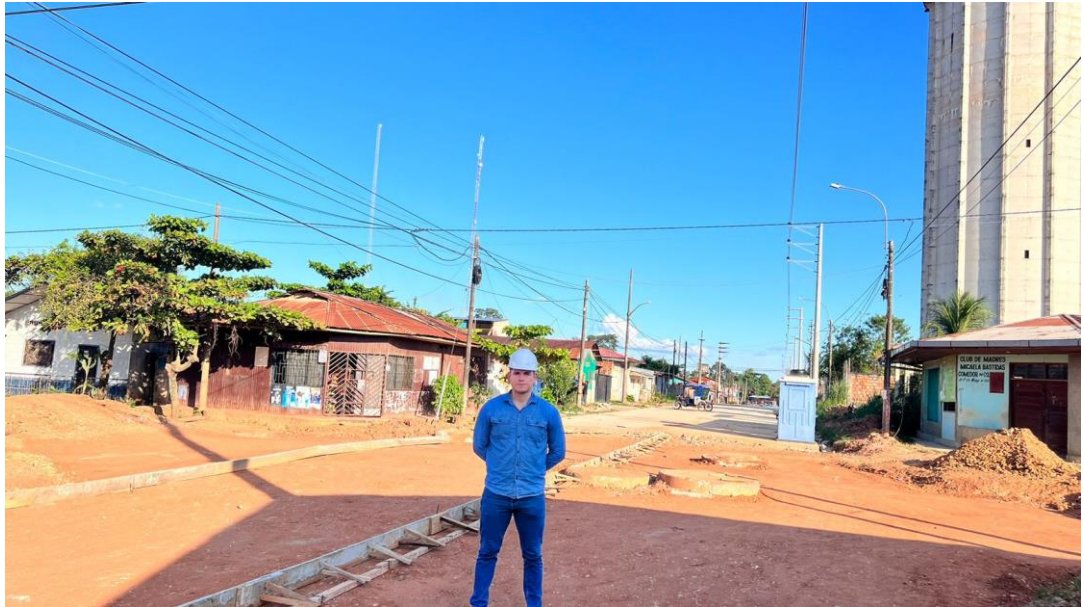
En la vista panorámica se puede observar los trabajos de encofrados de la loza del pavimento. Además, se observa la rasante con un CBR mejorado.
