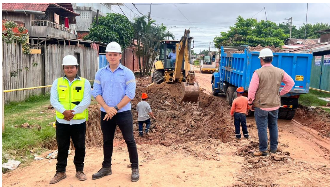
En la vista panorámica se observa los trabajos de la maquinaria utilizada para la mejora de la sub rasante, como es el CBR del suelo.
