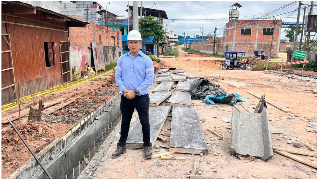
En la vista panorámica se puede observar los trabajos de concreto y acero en el sistema de drenaje de la pavimentación de la vía.
