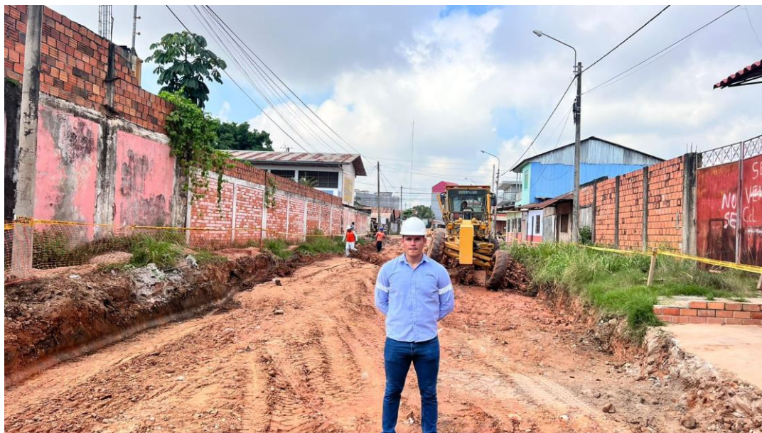
En la vista panorámica se observa los trabajos de conformación de la sub base, y base de la plataforma de rodadura con maquinaria para mejorar el CBR.
