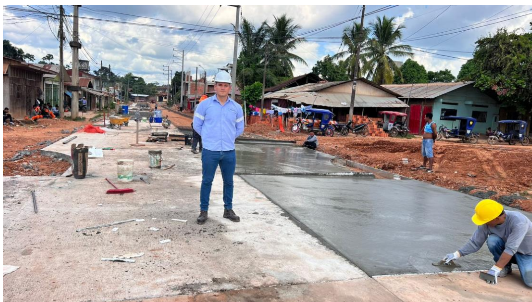
En la vista panorámica se puede observar los trabajos de concreto en la vía, además se observa los trabajos del acabado de los paños de concreto.
