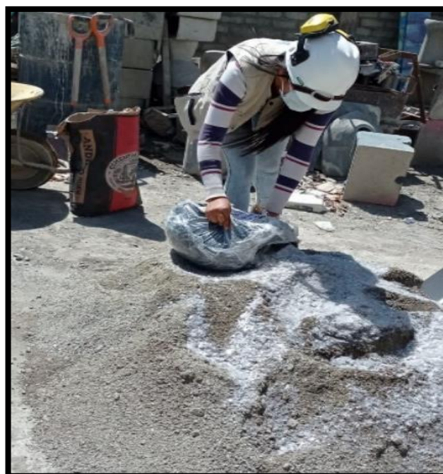
Fotografía 6. Mezcla de los agregados
