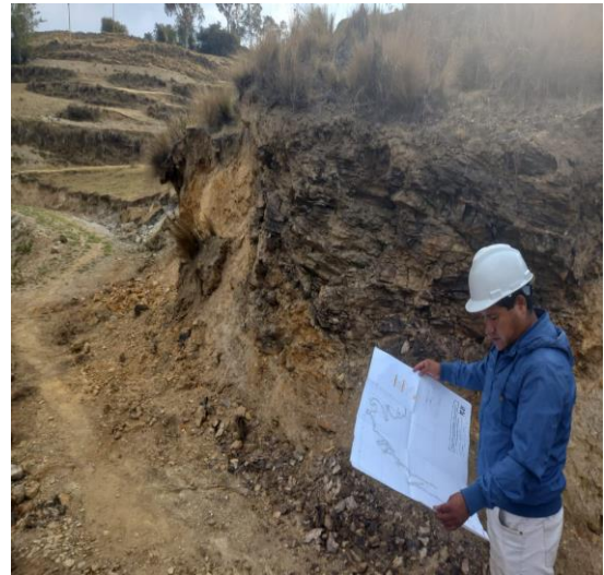
Se observa en otro punto de la carretera
