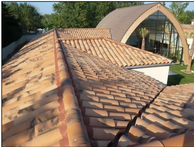
Figura 62 Cobertura de teja ceràmica
