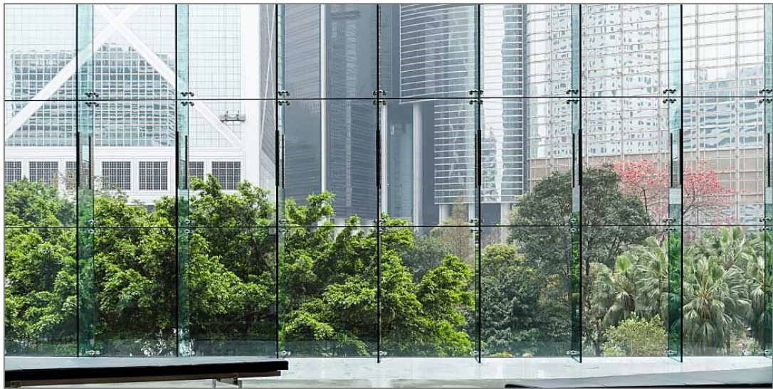
Figura 70 Panel de muro cortina
