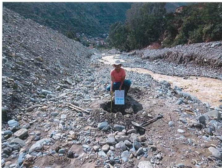
IMAGEN N° 08 – EXCAVACION DE LA CALICATA
