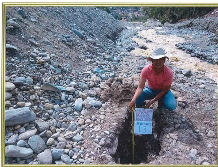
VISTA FOTOGRÁFICA DE LA CALICATA Nº 03
