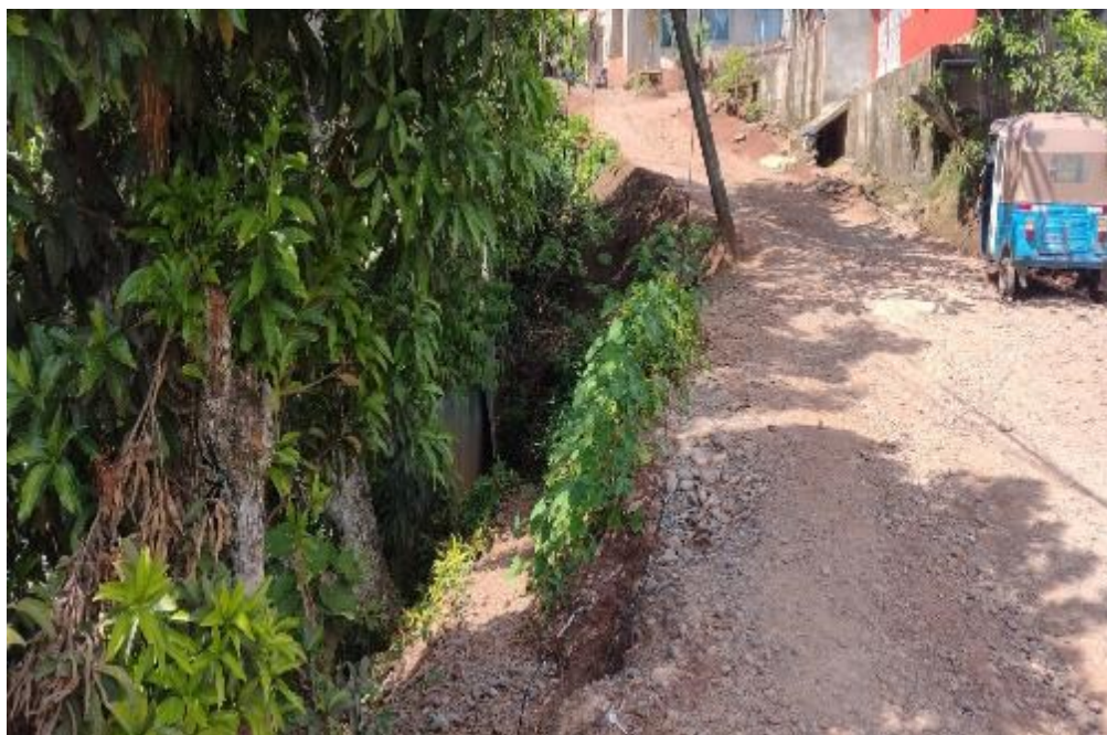
Vista del canal que utilizan como desagüe y a aturado el suelo
