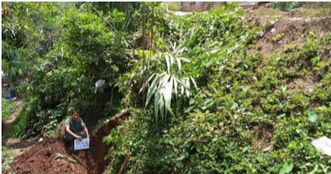
CALICATA 03 Km. 0+160 MURO DE CONTENCION COORDENADAS
