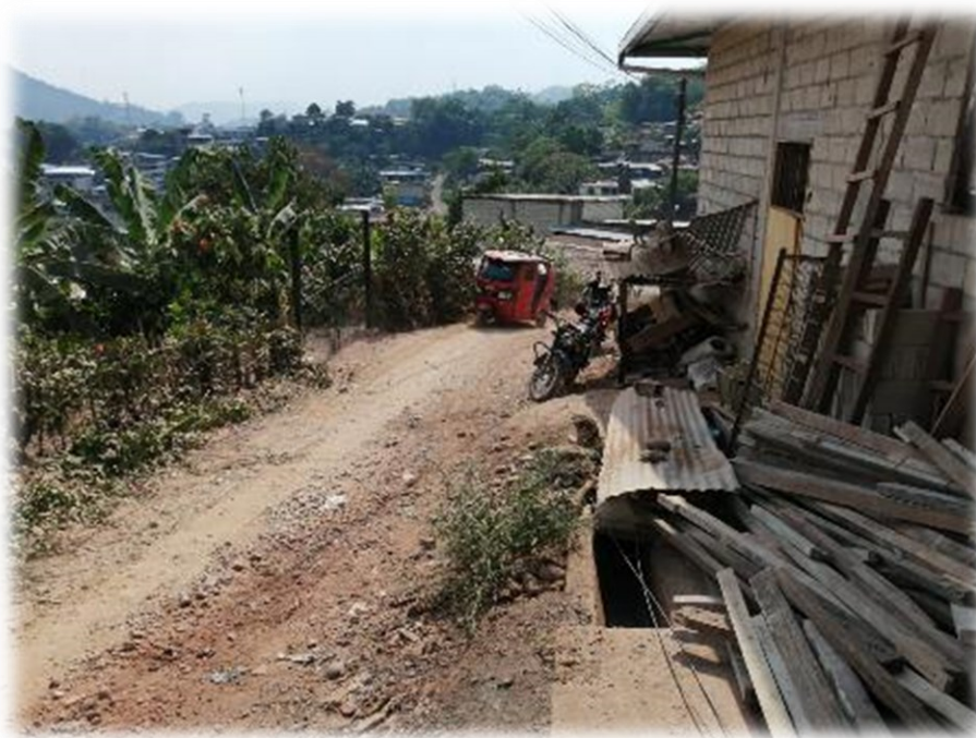
Vista de los espacios públicos con material de las viviendas, que se requieren su retiro para el trazo y replanteo del eje de vía.
