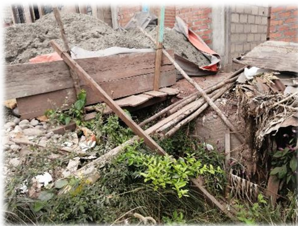
Vista de los espacios públicos invadido por las viviendas, se requiere el alineamiento para el trazo y replanteo
