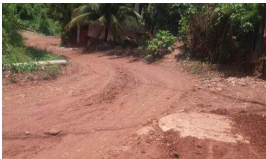
VISTA DEL AREA DEL PROYECTO KM. 0+160
