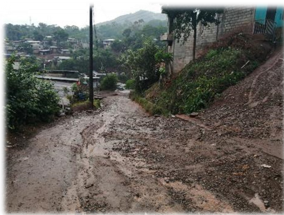
Vista de otro poste de energía eléctrica, dentro del alineamiento de la vía, que requiere su ubicación.
