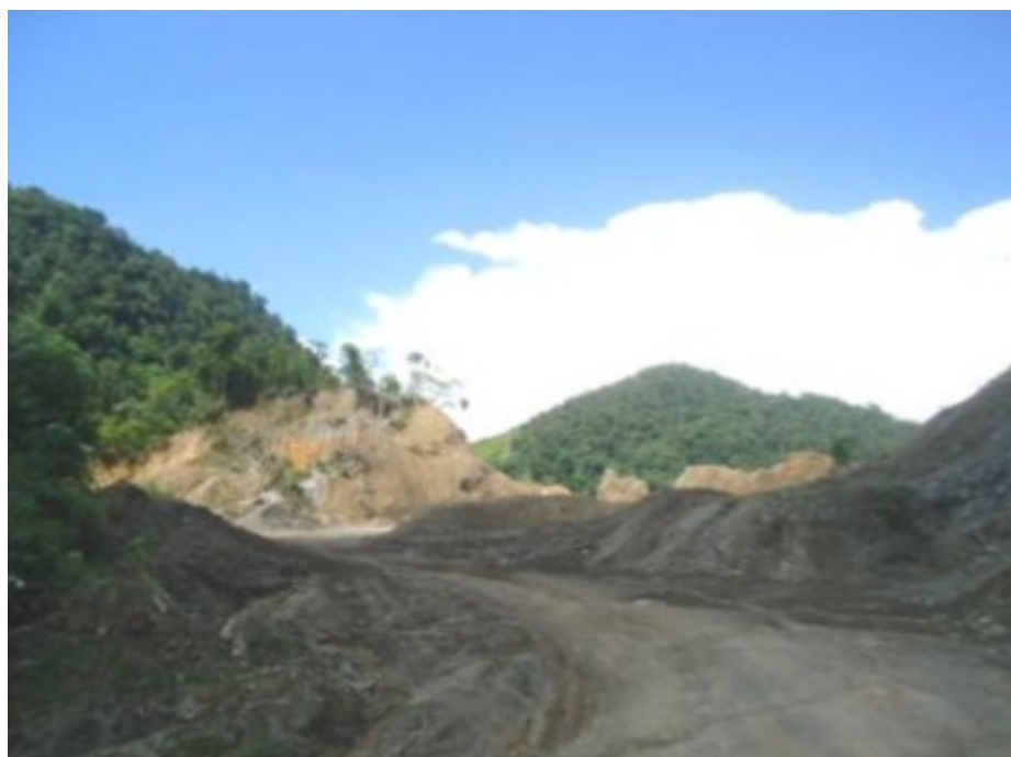
CANtera DE CERRO MOYANO, MATERIAL PARA SUB BASE Y BASE. COORDENADAS UTM ESTE 387,307.60 NORTE 8'978,007.10. DISTANCIA DE LA ZONA DEL PROYECTO A LA CANtera 9.60 KM.
