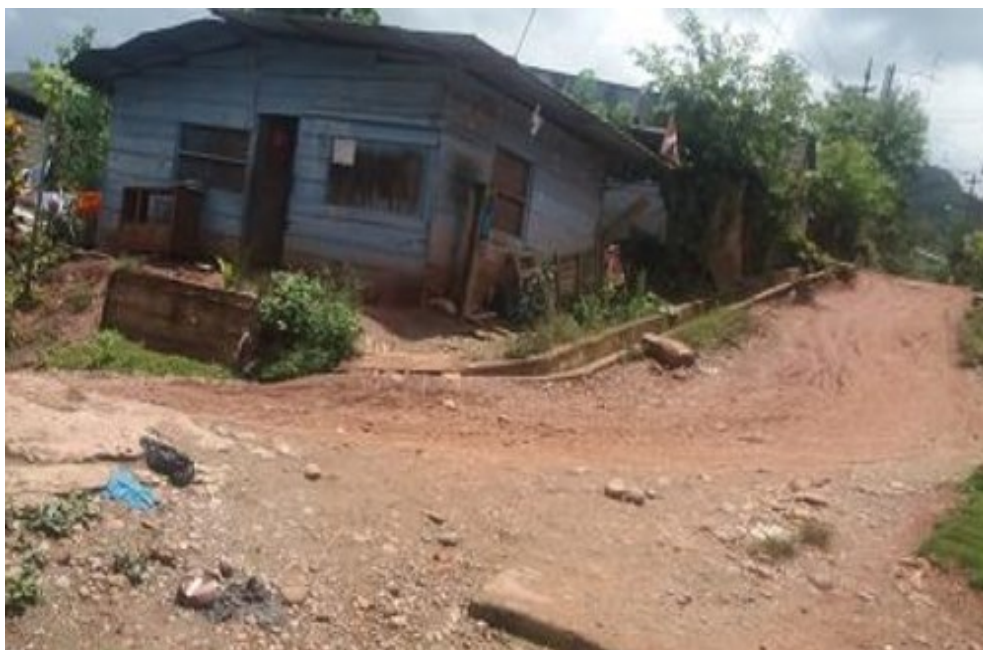
VISTA DEL AREA DEL PROYECTO KM. 0+250
