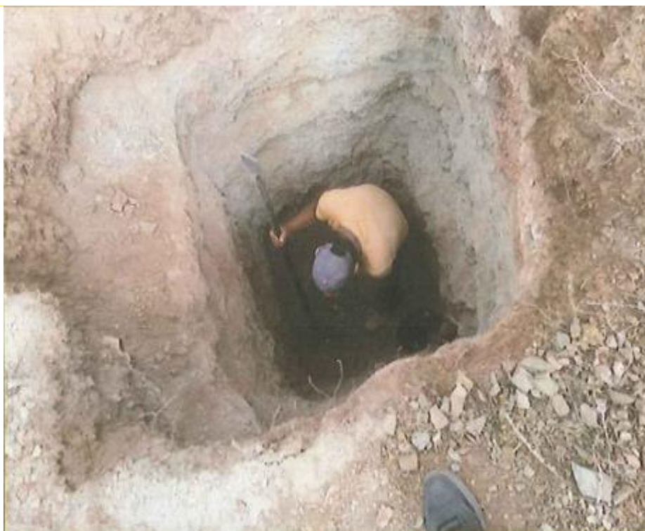
Vista fotográfica de la calicata N°2 – cerro San Cristóbal - san Luis - sector 04 - Amarilis
