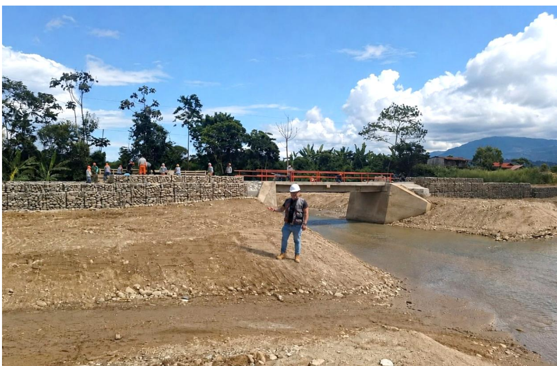
Fotografía 6: En la imagen, el investigador (tesista) señala la disposición geométrica de los muros tipo gavión que confinan lateralmente el terraplén permeable.
