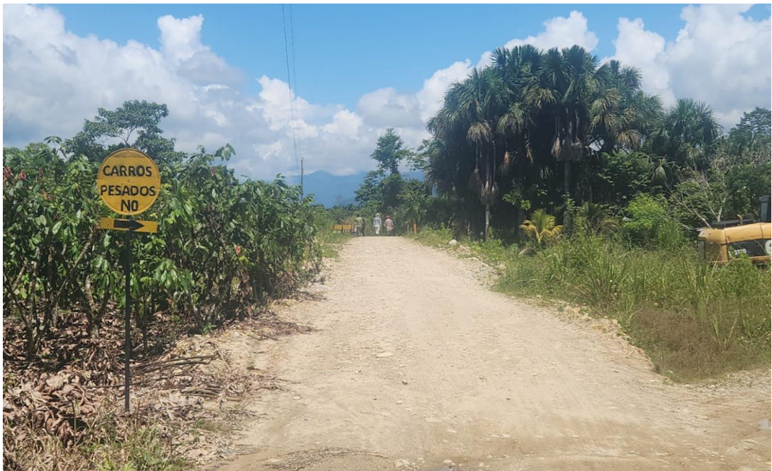
Fotografía 2: Vista del terraplén, se observa la vía de acceso antes de la ejecución del proyecto.
