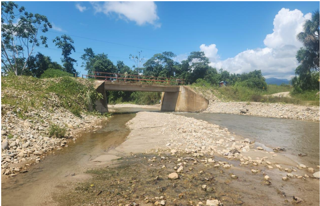
Fotografía 1: Vista de terraplén y puente desde aguas abajo.
