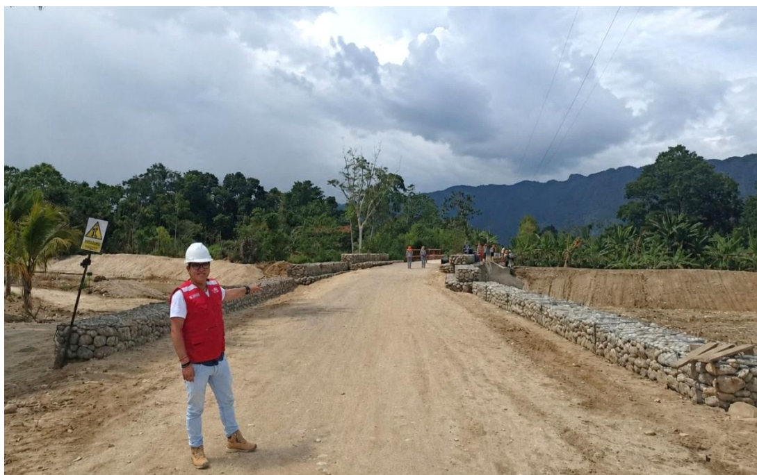
Fotografía 5: Vista panorámica de la plataforma de acceso al puente carrozable. En la imagen, el investigador (tesista) señala los muros tipo gavión, la cual fue su propuesta de investigación.
