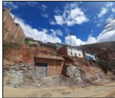
Tramo de muestra del proyecto donde se aprecia la seccion transversal
