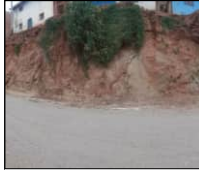
Talud de la via de estudio donde se observa las unidades de viviendas
