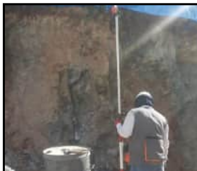
Realizacion de levantamiento topografico
