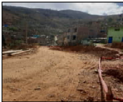
Viviendas a desnivel
