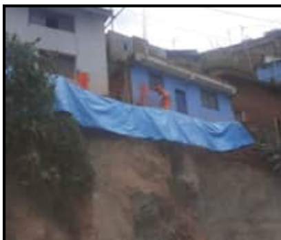
Realizacion de extraccion de muestra de suelo
