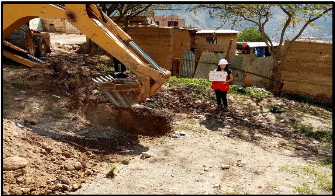
Punto de extracción de la calicata 6, ubicada en Jr. Andrés A. Cáceres en el Asentamiento Humano La Florida, en el centro poblado de Las Moras, Distrito y Provincia de Huánuco.
