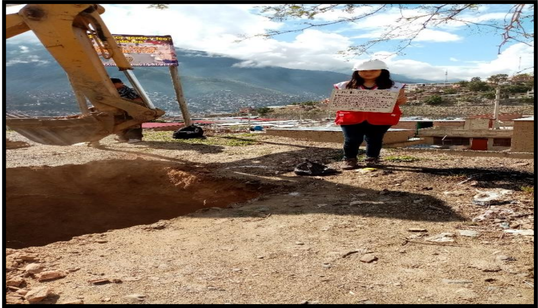
Se observa la excavación de la calicata en el Asentamiento Humano La Florida, en el centro poblado de Las Moras, Distrito y Provincia de Huánuco para posteriormente realizar los ensayos correspondientes para determinar los tipos de suelos y la capacidad portante.
