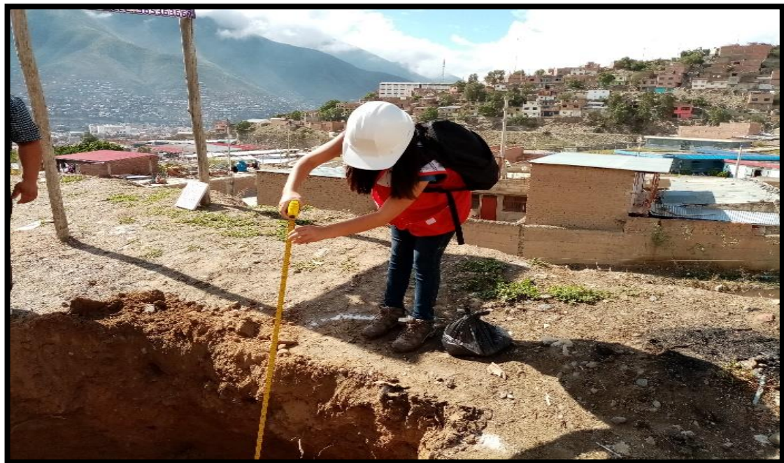
Se observa la excavación de la calicata en el Asentamiento Humano La Florida, en el centro poblado de Las Moras, Distrito y Provincia de Huánuco.
