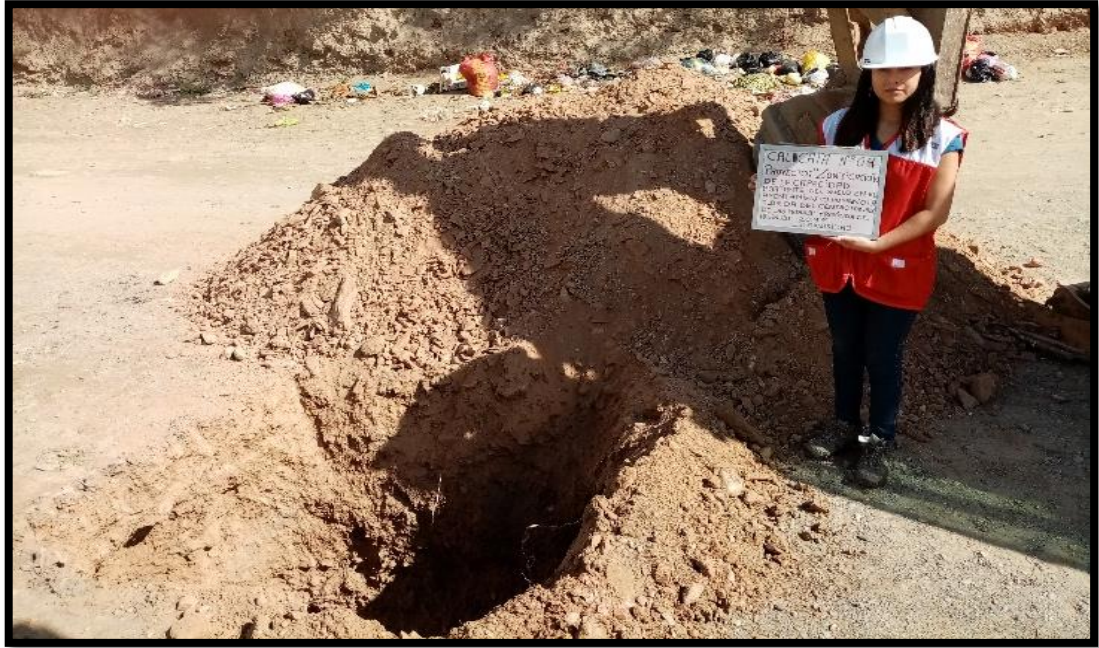
Punto de extracción de la calicata 4, ubicada en Jr. Antonio José de Sucre en el Asentamiento Humano La Florida, en el centro poblado de Las Moras, Distrito y Provincia de Huánuco.
