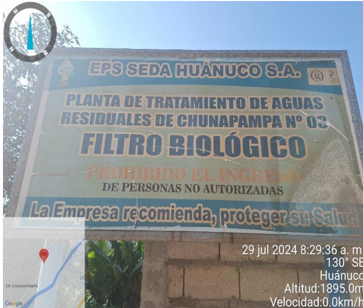
Planta de Tratamiento de Aguas Residuales Chunapampa
