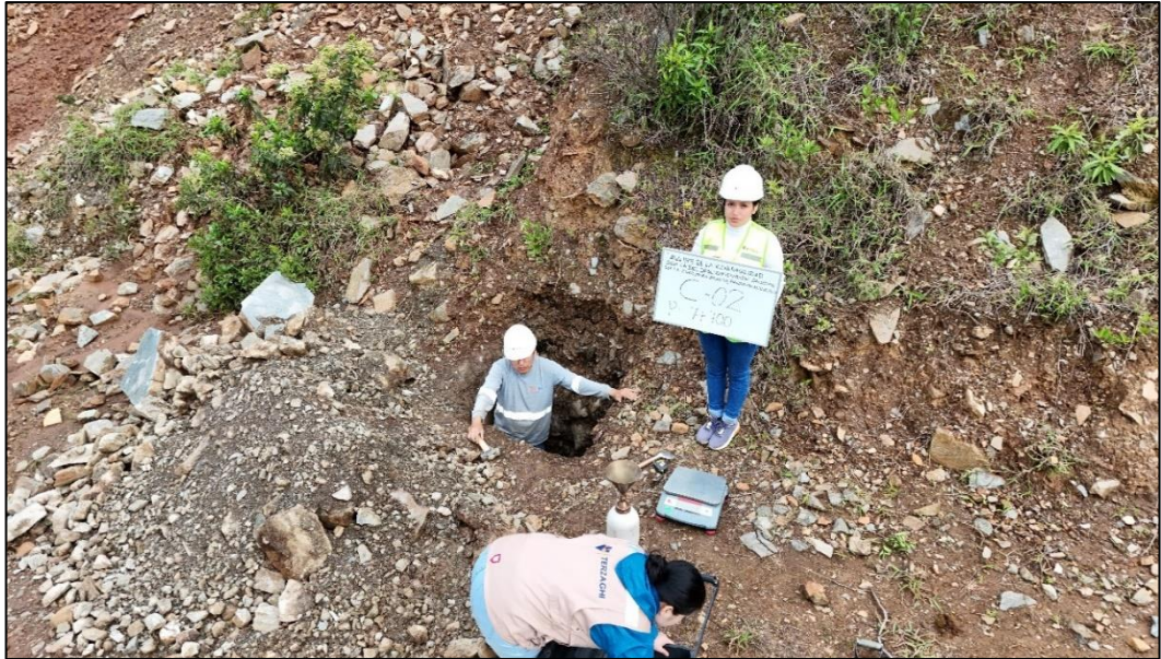
Captura del procedimiento de evaluación de densidad con el método del cono de arena. Se observa el equipo técnico en ejecución y la delimitación del área de prueba.
