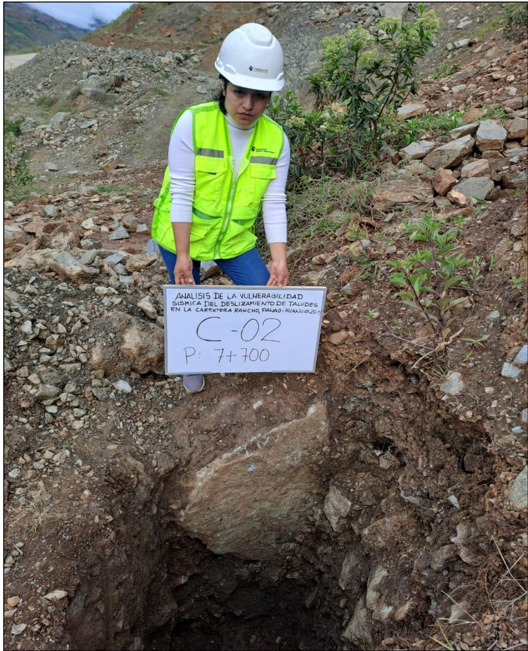
Evidencia del trabajo de excavación manual y controlado para la apertura de la calicata, con fines de muestreo y caracterización física del suelo.
