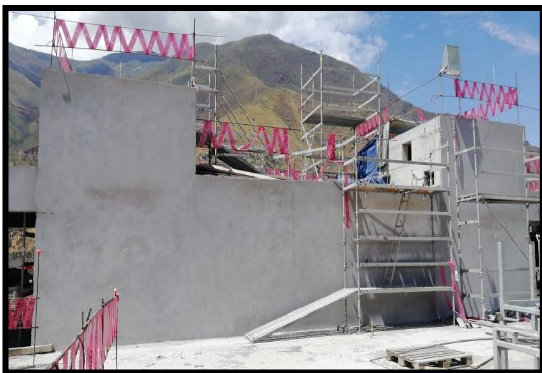
Trabajos en Arquitectura en proceso (Muros de ladrillo y tarrajeo en parapetos), tarrajeo y albañilería en placas de escalera ha finalizado. Sector A, séptimo nivel.
