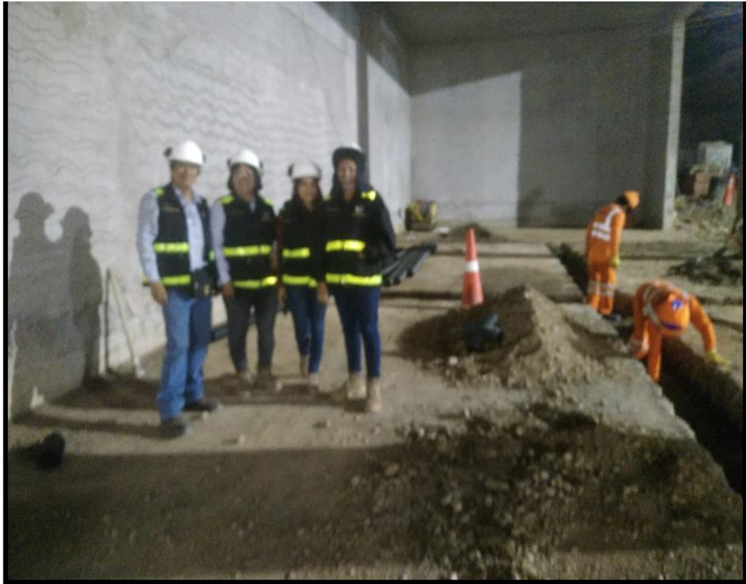
Se observa los trabajos respectivos para su posterior colocación de geocompuesto ubicación de la Central de Oxígeno.
