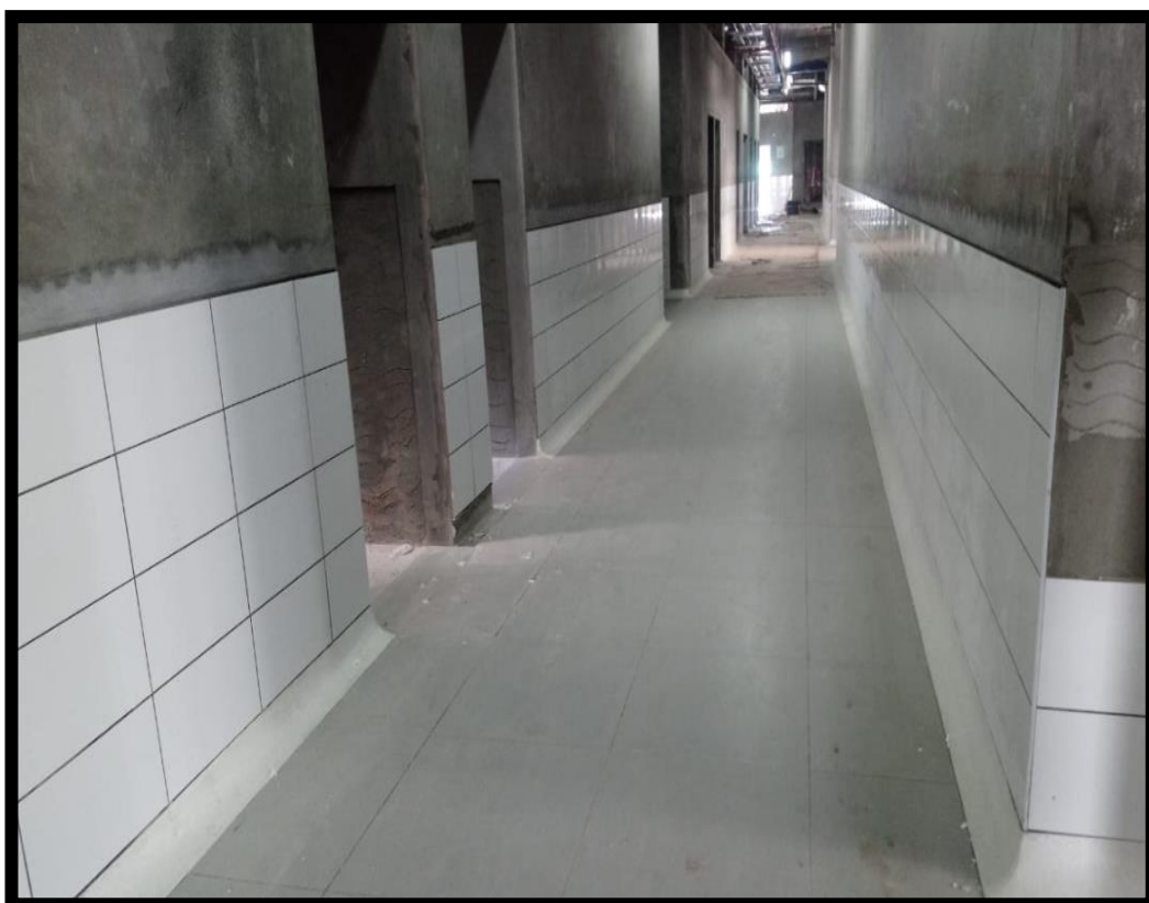
Enchape de pisos e instalación de contrazocalo sanitario terrazo. Nivel 2, Sector A
