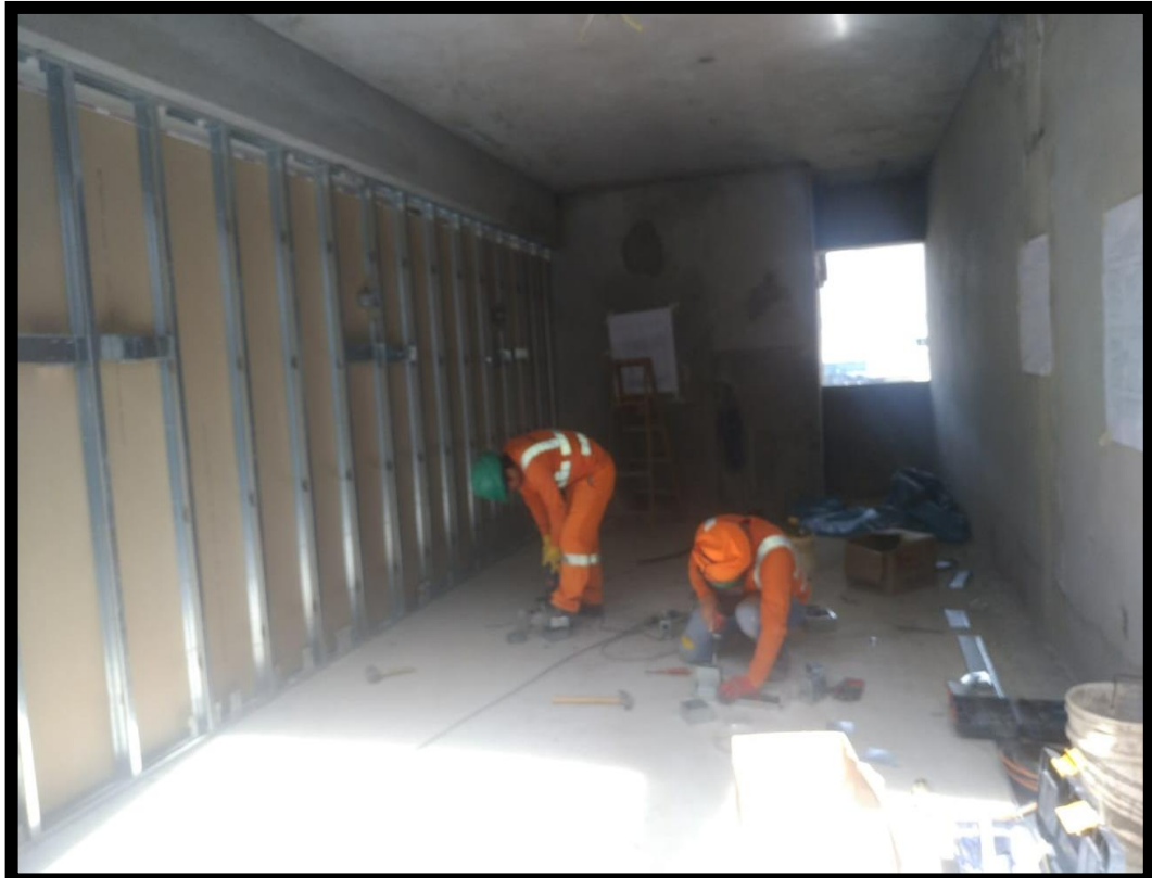
Elaboración los pases para cables eléctricos con Tubos de Acero Galvanizado Conduit IMC
