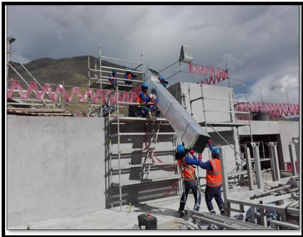
Colocación de ductos en montante – Nivel 07 - Sector A.
