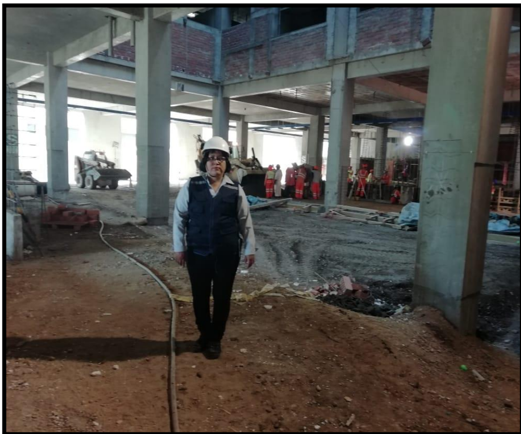
Supervisión de los trabajos ejecutados por el Contratista la compactación de la Base Granular
