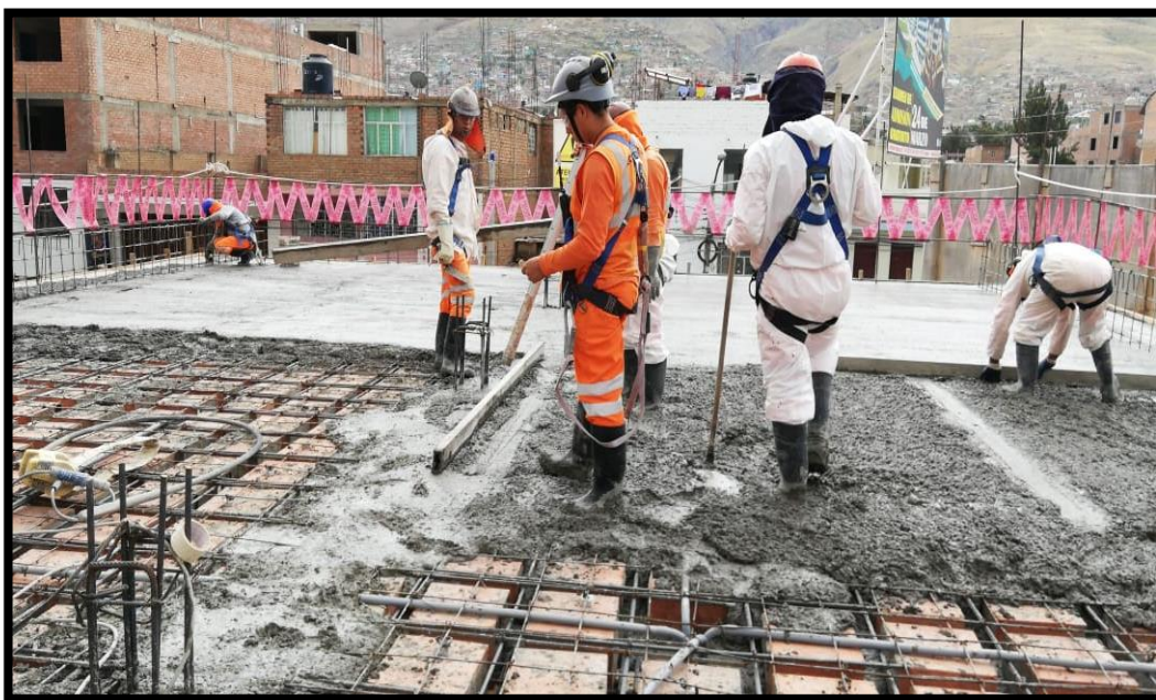
Vaciado de concreto f'c=210 \text{ kg./cm}^2 . Losa aligerada.
