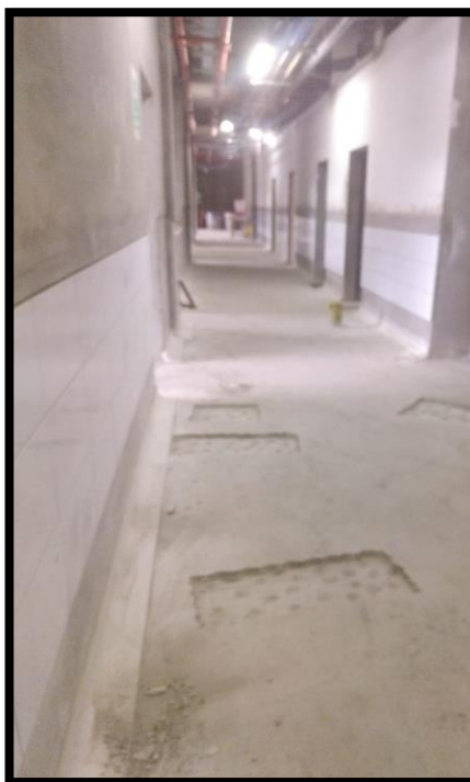
Se observa la existencia de los cajoneos en contrapiso.
