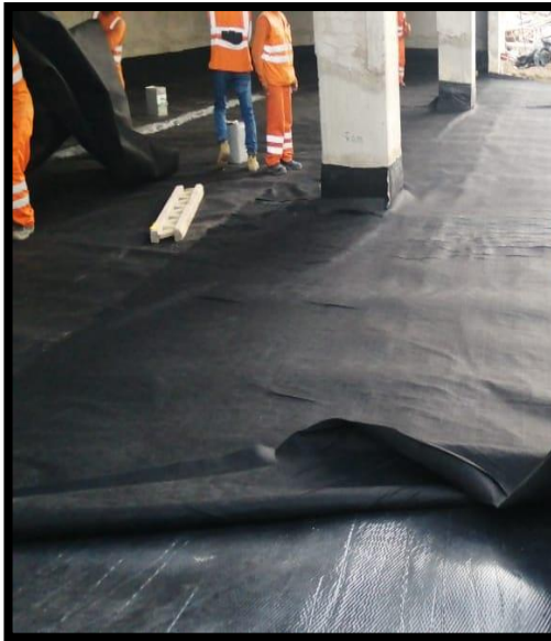
Colocación de geocompuesto luego el geotextil posterior el relleno y compactación
