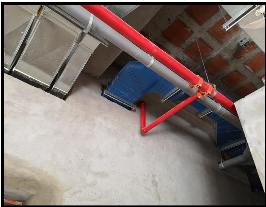
Red de tubería de ACI - Sector A-NIVEL 2
