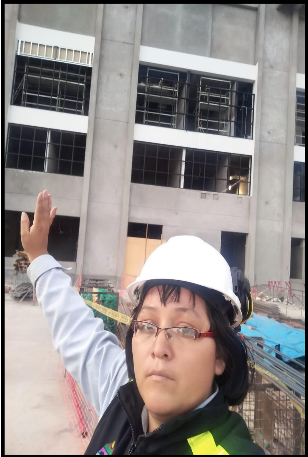
Tarrajeo exterior finalizada. - Vista planta de edificio.
