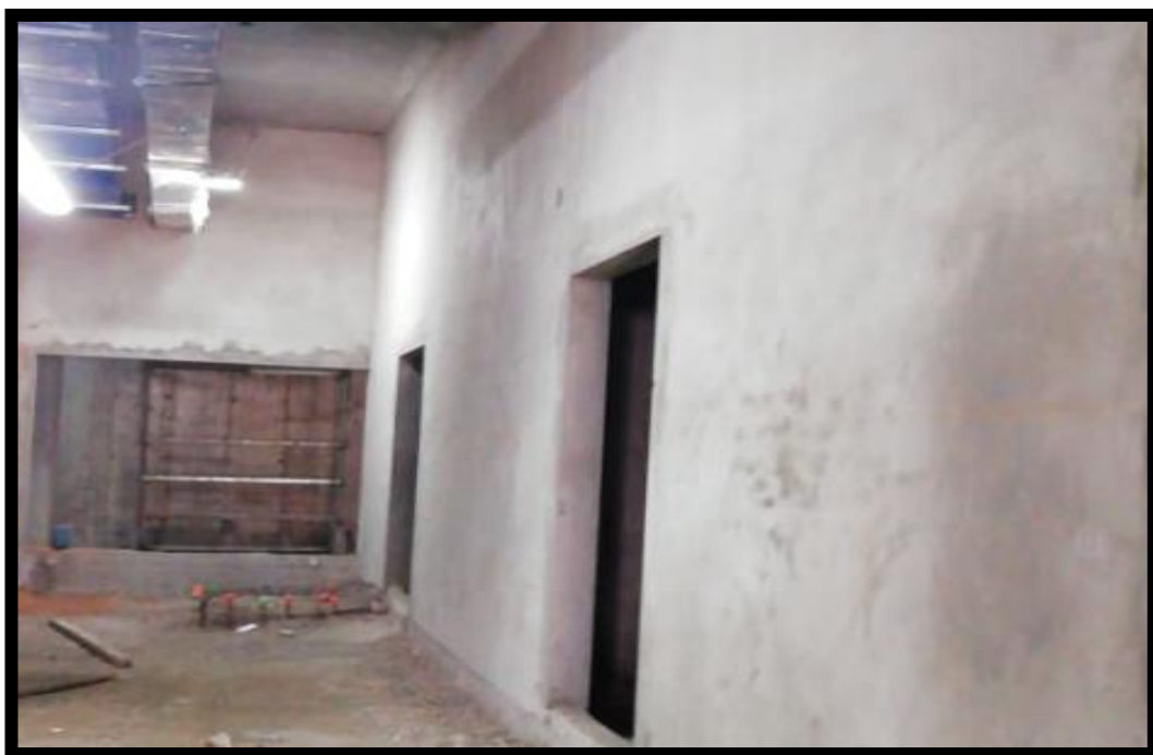
Trabajos en arquitectura en proceso (Albañilería terminada, tarrajeo terminado).
