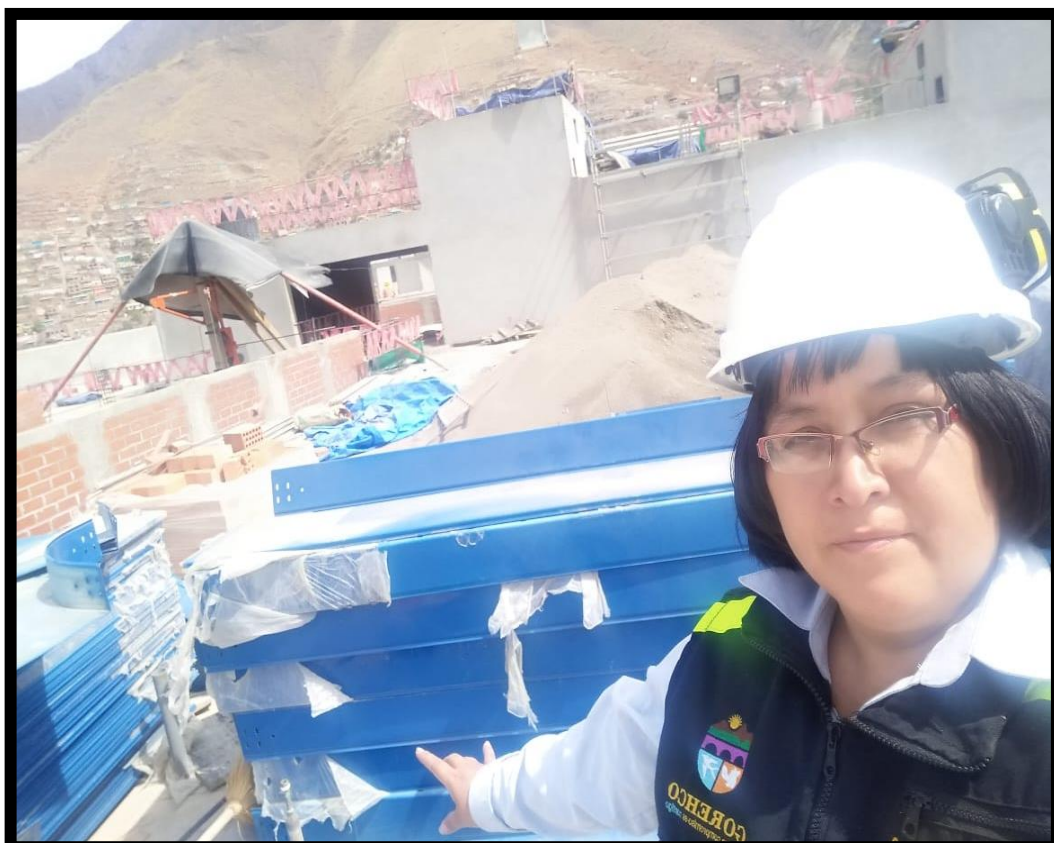
Vista panorámica de Bandeja de Comunicaciones Almacenadas en la Azotea
