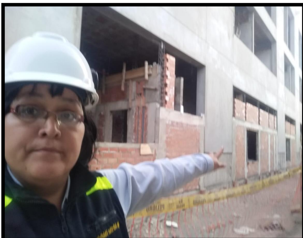
Trabajos en arquitectura en proceso en el Sector B, Nivel 2.
