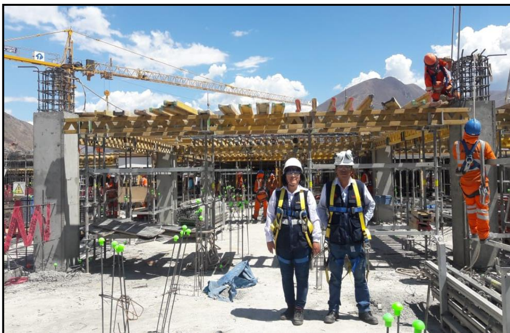
Vista de Encofrado de Losas del sexto Nivel
