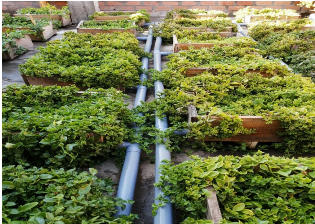
Acondicionando el techo verde en el predio
