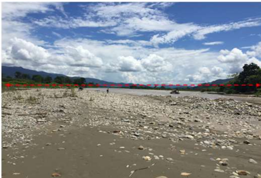
Vista panorámica del Puerto Malatoa, transbordo mediante lancha motorizada Donde se proyecta el puente modular L=165.72 m.
