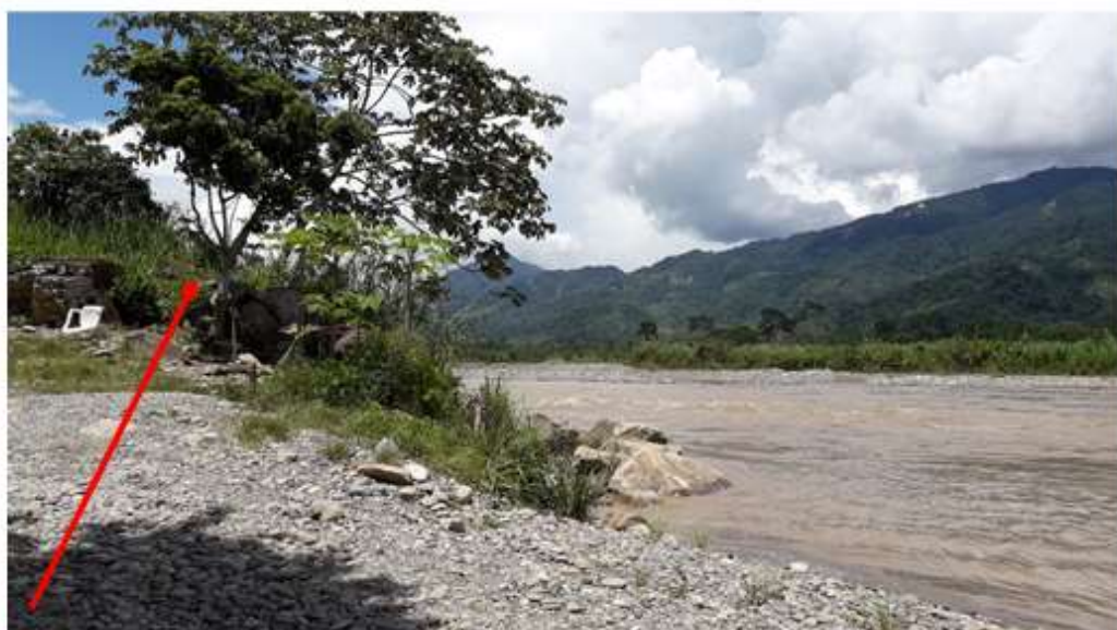
Vista donde se proyectara el Estribo N° 01 del Puente.
