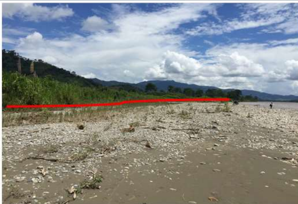
Vista panorámica del borde de cause del río Monzón, donde se proyecta muro de protección (Enrocado) L=830 ml. + Descolmatación y encauzamiento
