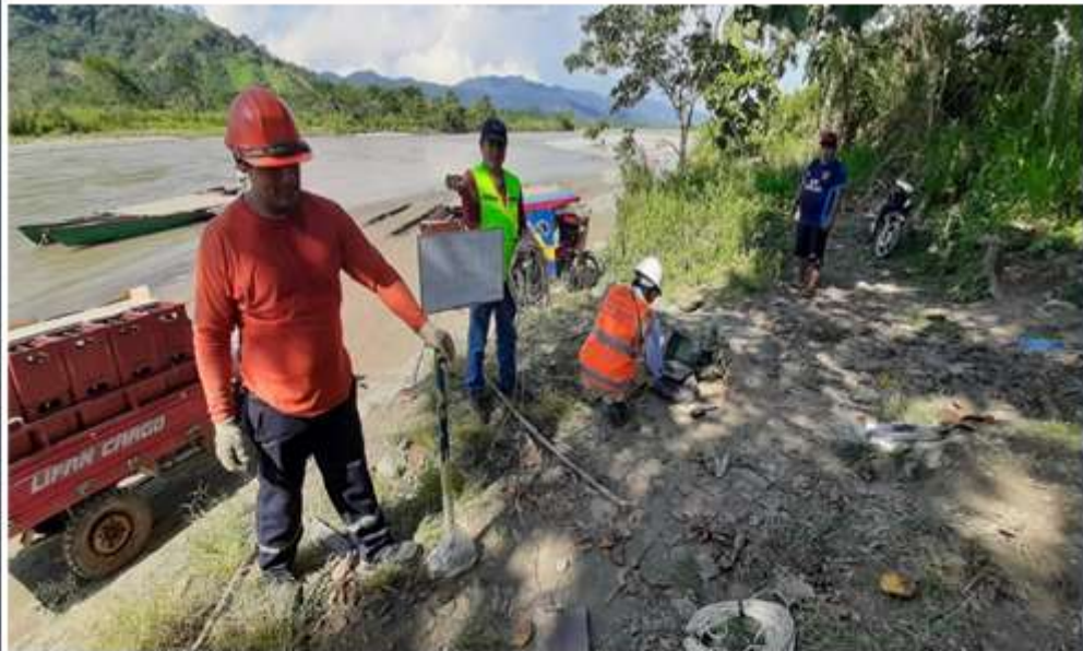
Vista fotográfica de la instalación de equipos para la prueba de campo de estudio de suelo por el método del sondeo eléctrico vertical margen Derecho
