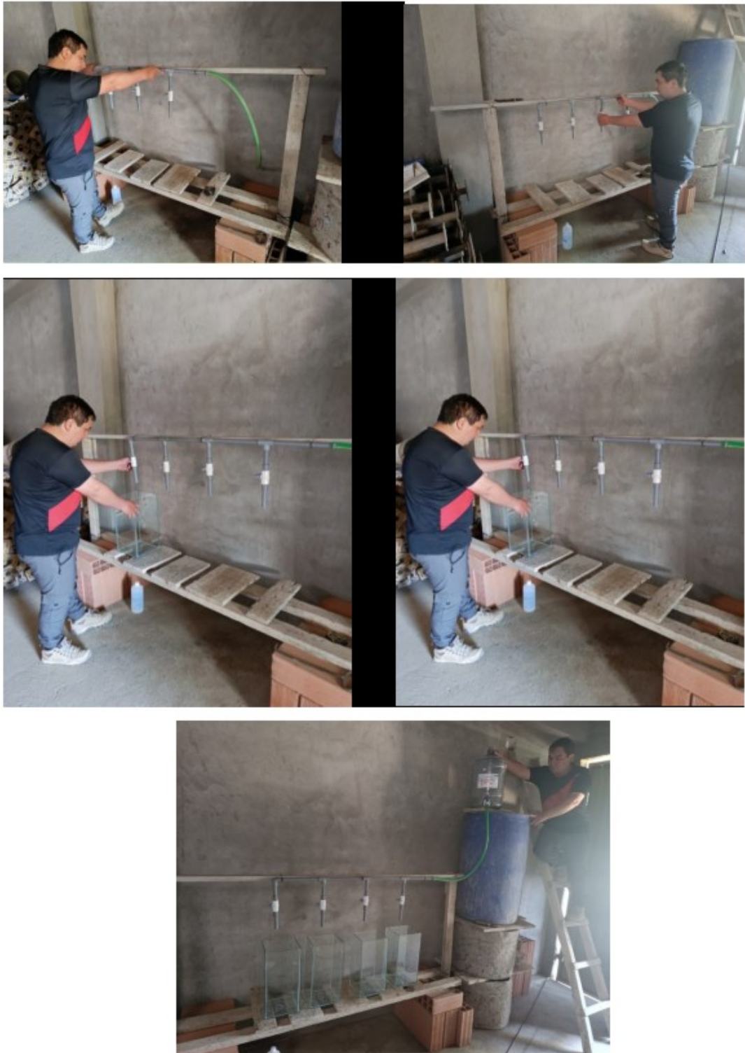
Vistas del proceso de armado de conductos para la distribución de aguas residuales de lavaderos de vehículos
