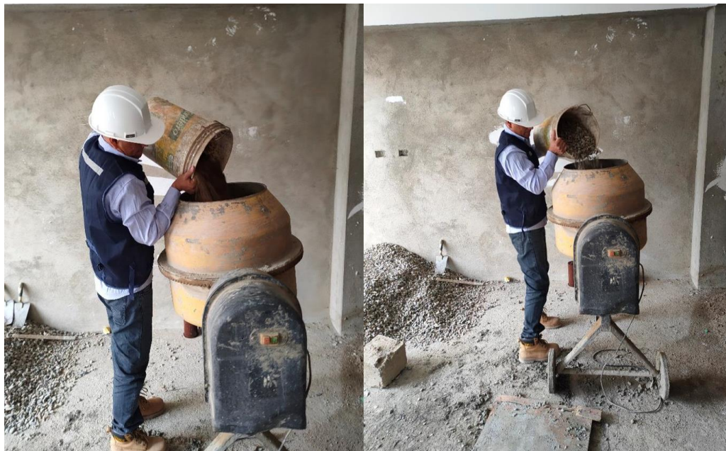
Elaboración de concreto f'c 210 kg/cm con adición de fibras de acero, se adiciona los agregados finos y gruesos al trompo
