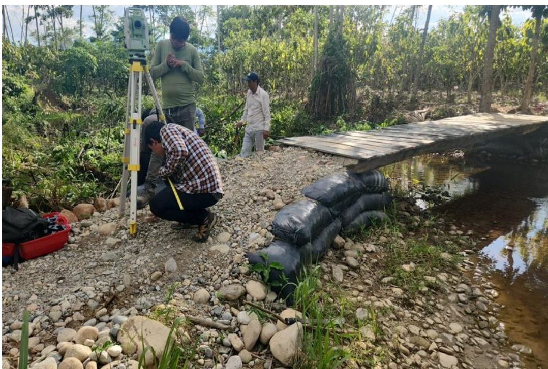
Verificación del apoyo lateral de salida de la pasarela peatonal existente del tramo delimitado del camino afirmado.
