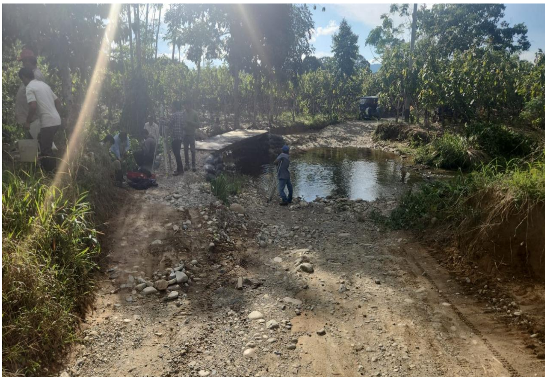
Salida de la pasarela peatonal existente en el tramo delimitado del camino afirmado.
