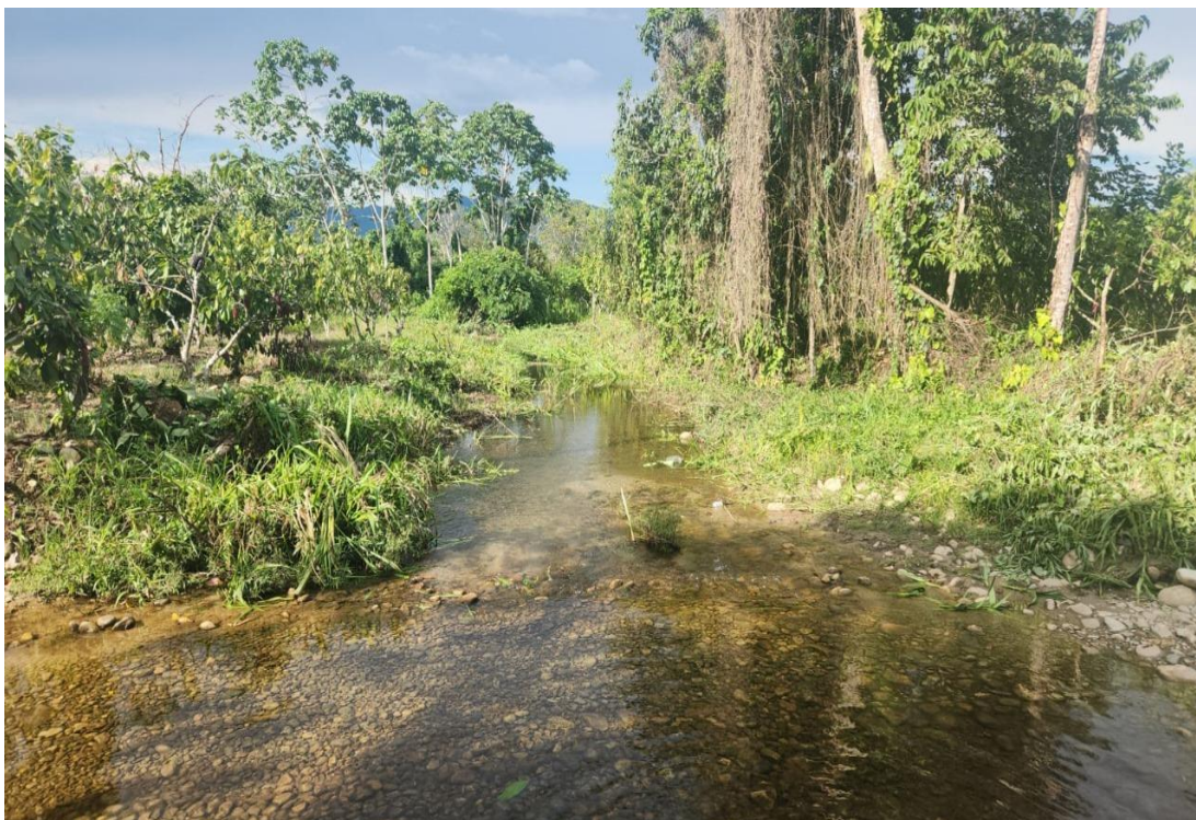
Verificación del cauce del río de la pasarela peatonal existente del tramo delimitado del camino afirmado.
