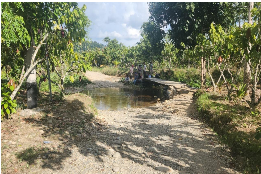
Ingreso de la pasarela peatonal existente en la progresiva 0+040 del tramo delimitado del camino afirmado.
