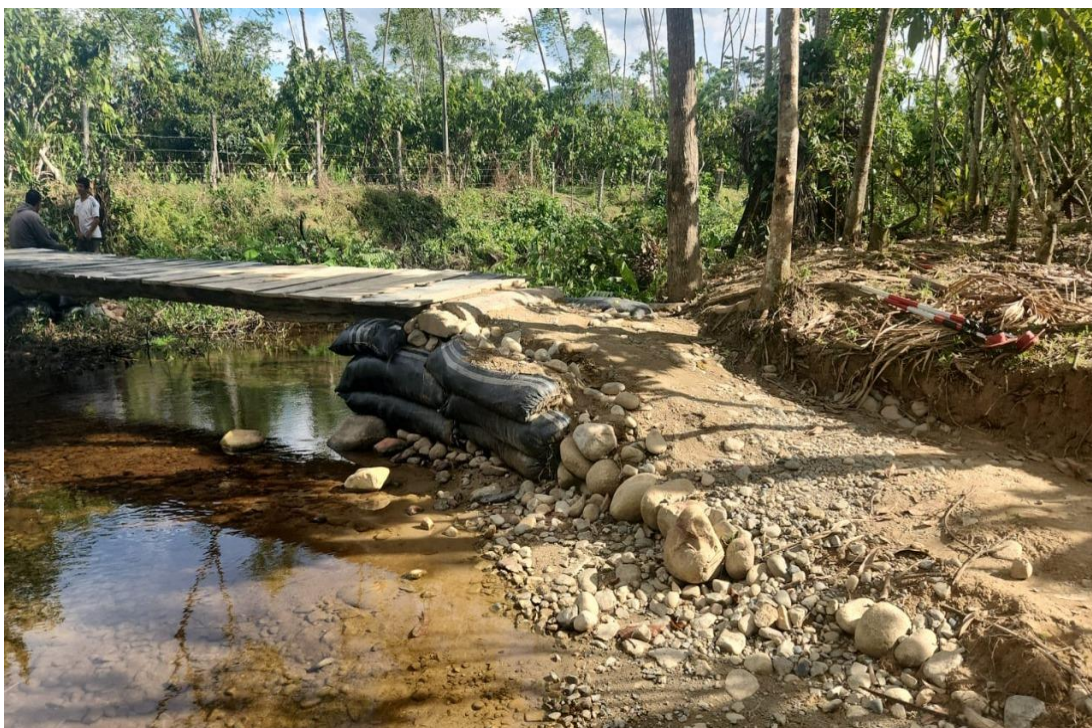
Verificación del apoyo lateral de entrada de la pasarela peatonal existente del tramo delimitado del camino afirmado.
